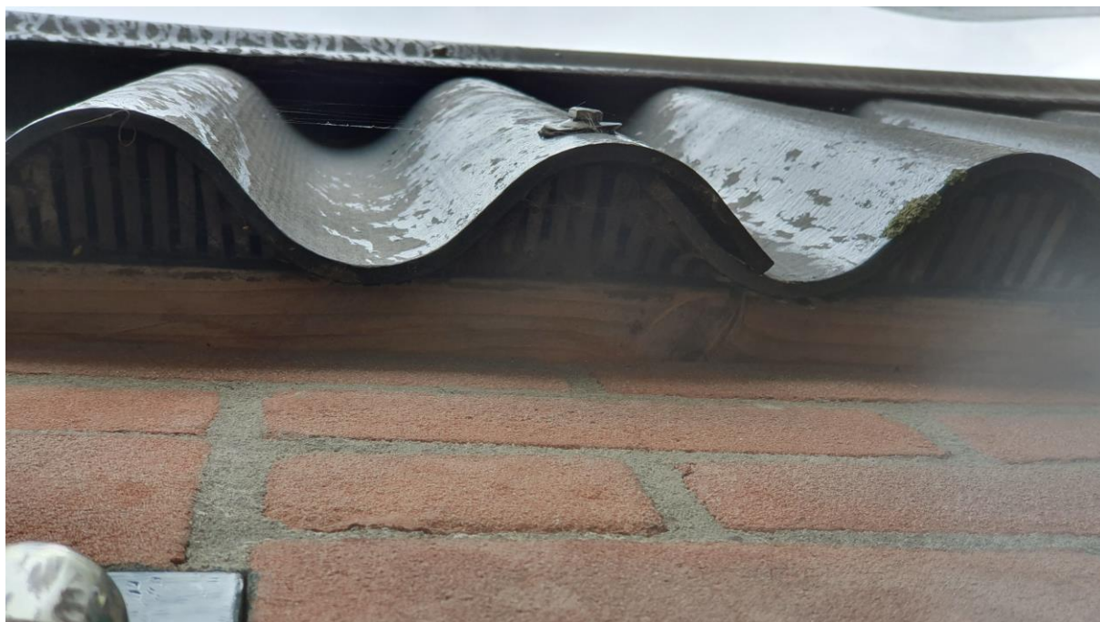
Figuur 4.2.2. Op de Aan de onderzijde van de golfplaten is vogelschroot aanwezig.
