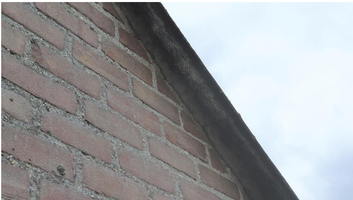
Figuur 4.2.6. De golfplaten sluiten nauw aan op de kopgevels van de berging aan het woonhuis.
