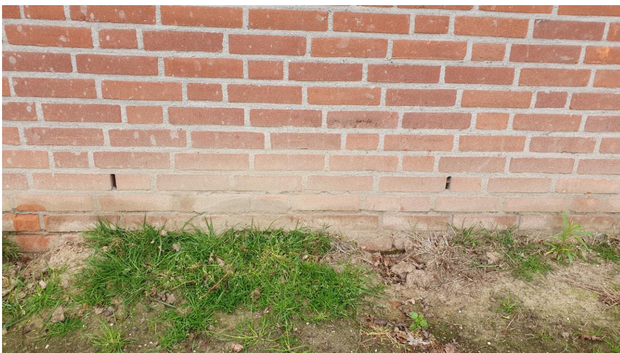
Figuur 4.2.4. Open stootvoegen zijn aanwezig op een hoogte van ongeveer 20 cm.
