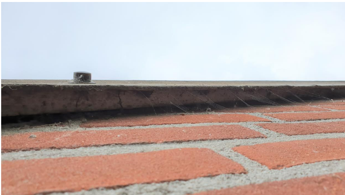
Figuur 4.2.3. De windveer sluit nauw aan op een lat aan de muur.
