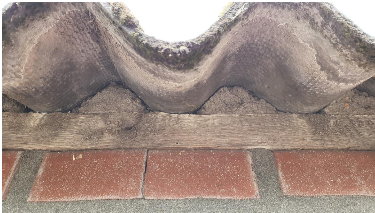
Figuur 4.2.1. Onder de golfplaten is vogelschroot, cement of een metalen strip aanwezig.
