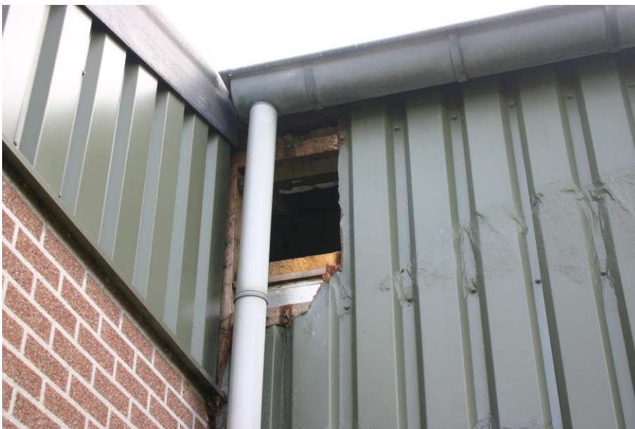
Figuur 4.2.2. Aan de noordoostzijde, op de kopse kant van de westelijk gelegen stal, bevindt zich een opening naar de ‘zolderruimte’. Hierin wordt stevig geventileerd.
