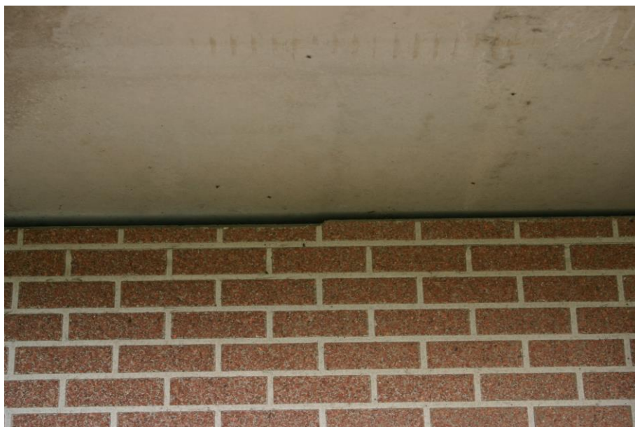
Figuur 4.2.5. Aan de noordzijde van de oostelijk gelegen stal is de spouw van boven geheel open. Hierdoor heerst er een te tochtig klimaat voor vleermuizen.
