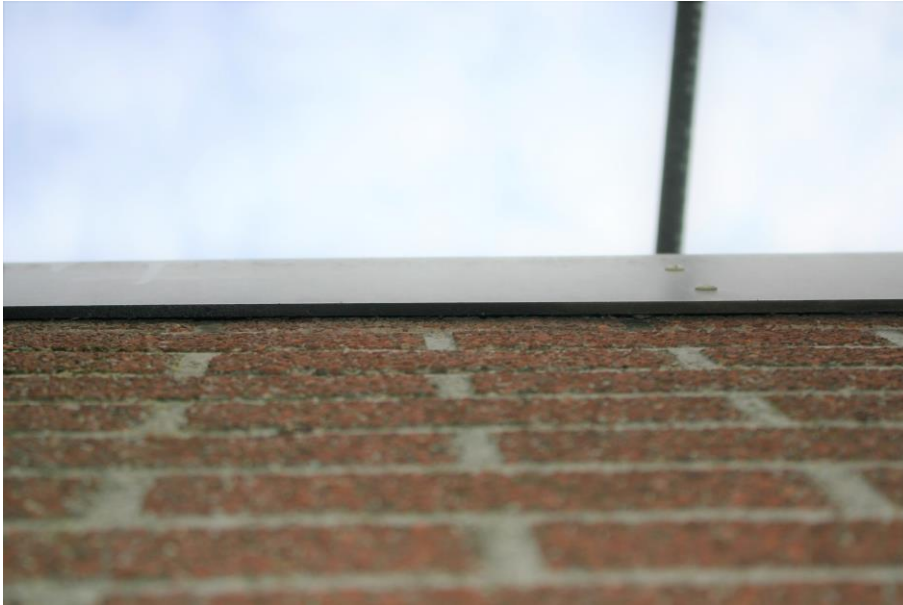
Figuur 4.2.3. De trespa rondom de stallen kiert nergens, waardoor er hier geen plaats voor vleermuizen om in te kruipen.
