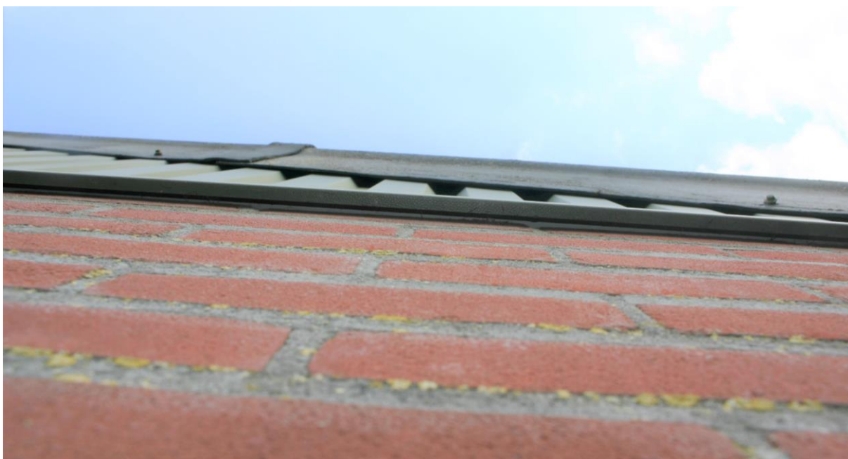
Figuur 4.2.2. Nauw aansluitende gevelbekleding aan de gevel.
