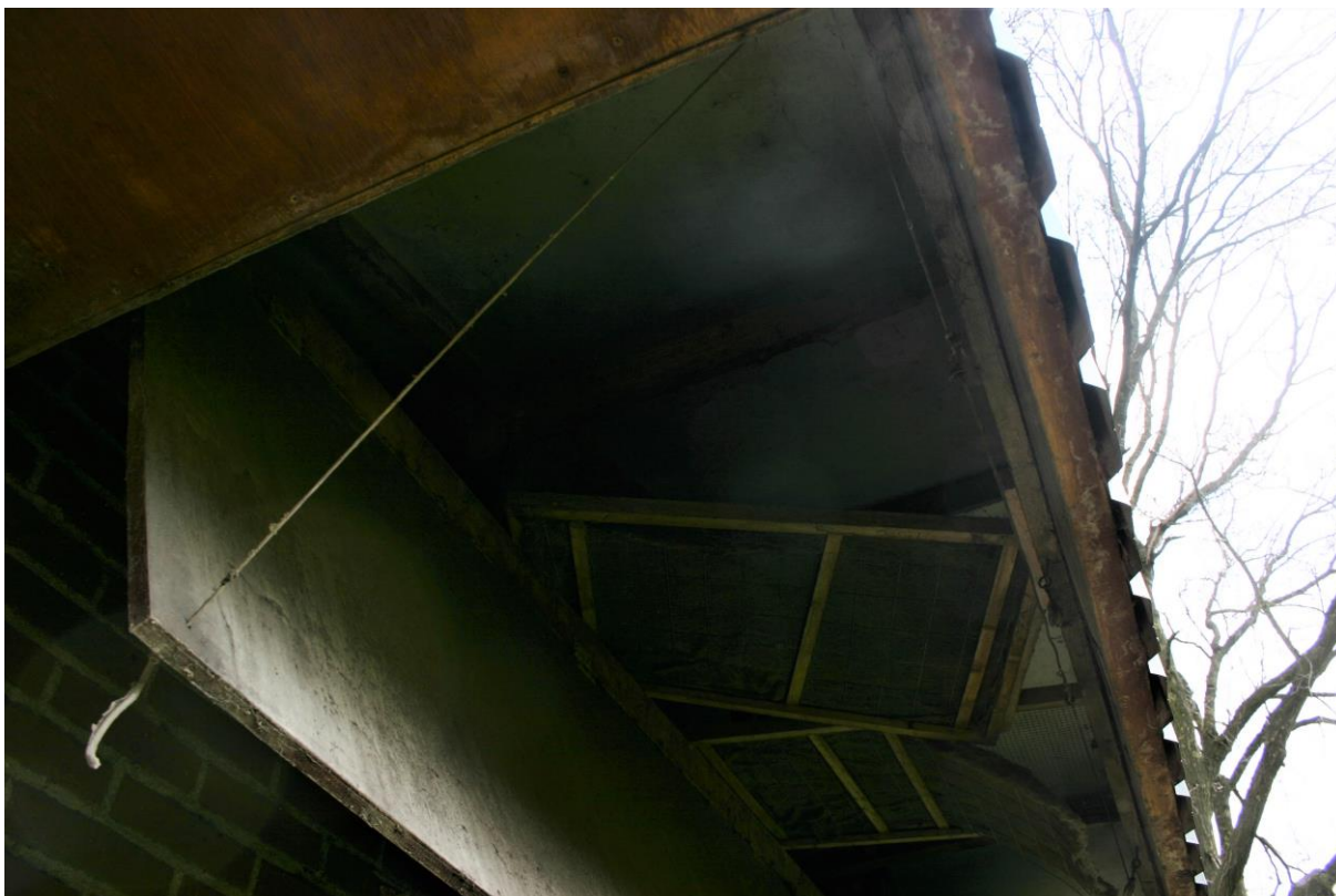
Figuur 4.2.4. De open plafondklep kan toegang verlenen aan vogels of andere dieren. Uit nadere inspectie met zaklamp, ladder en boomcamera bleek echter dat er geen vogelnesten aanwezig zijn.
