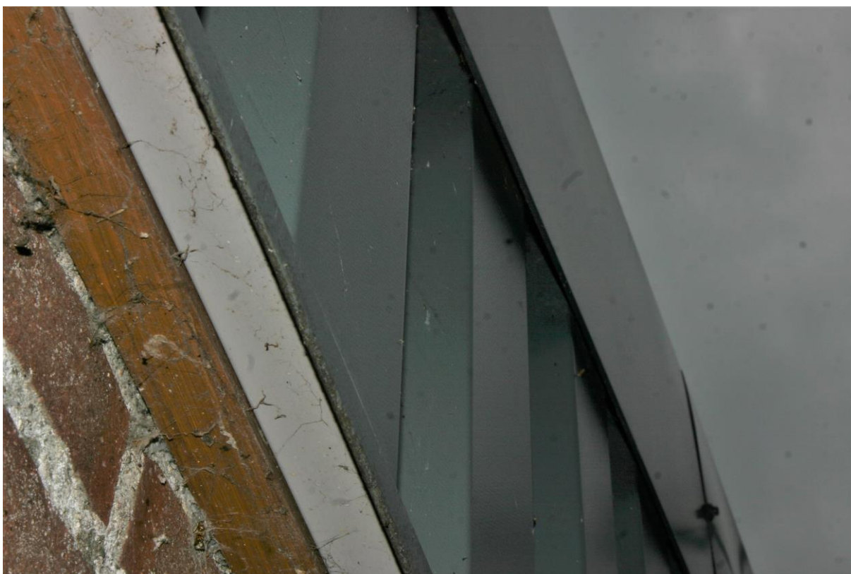
Figuur 4.2.4. De kopse kanten aan de noordzijde hebben een damwandplaten gevelbekleding en is van onderen afgesloten met een houten lat.
