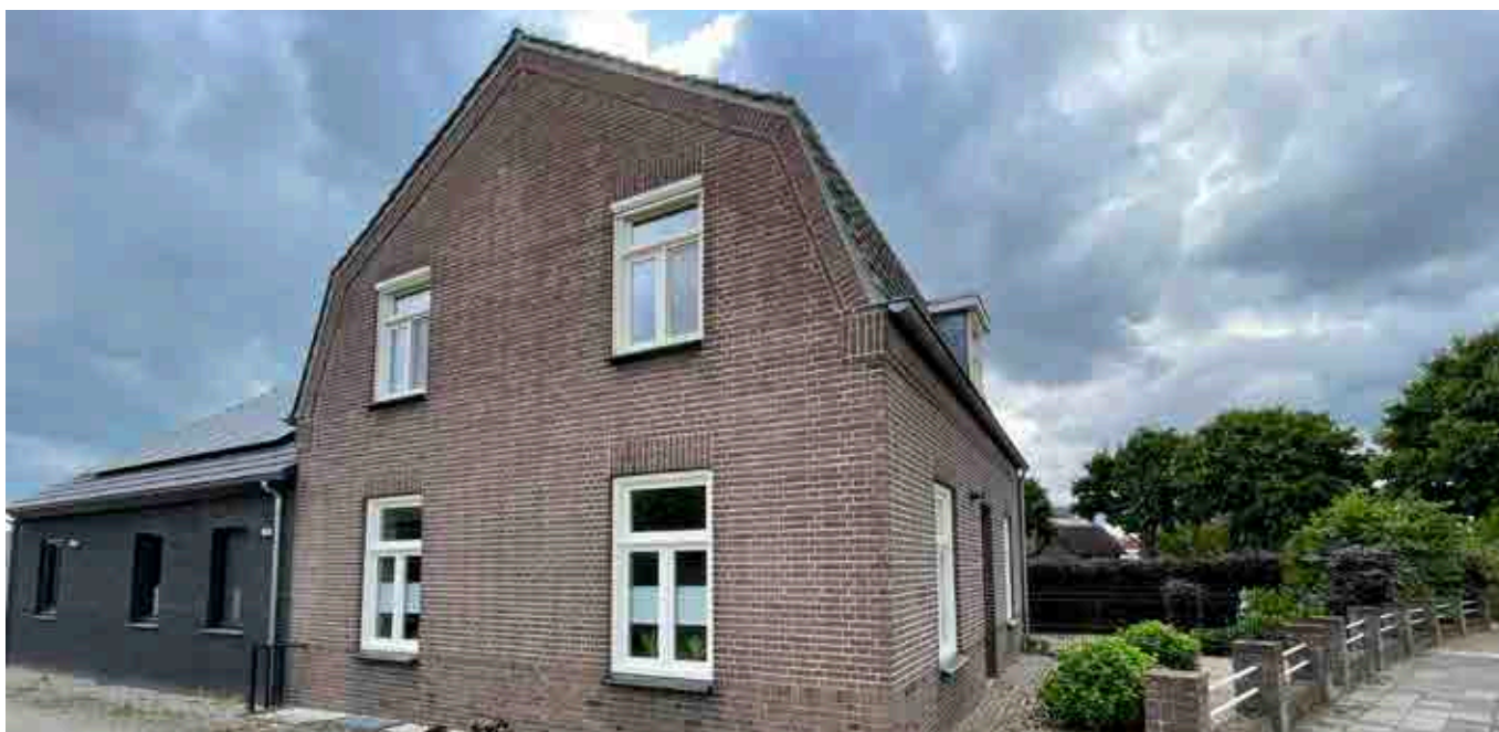
woonhuis aan de Albionstraat 46
