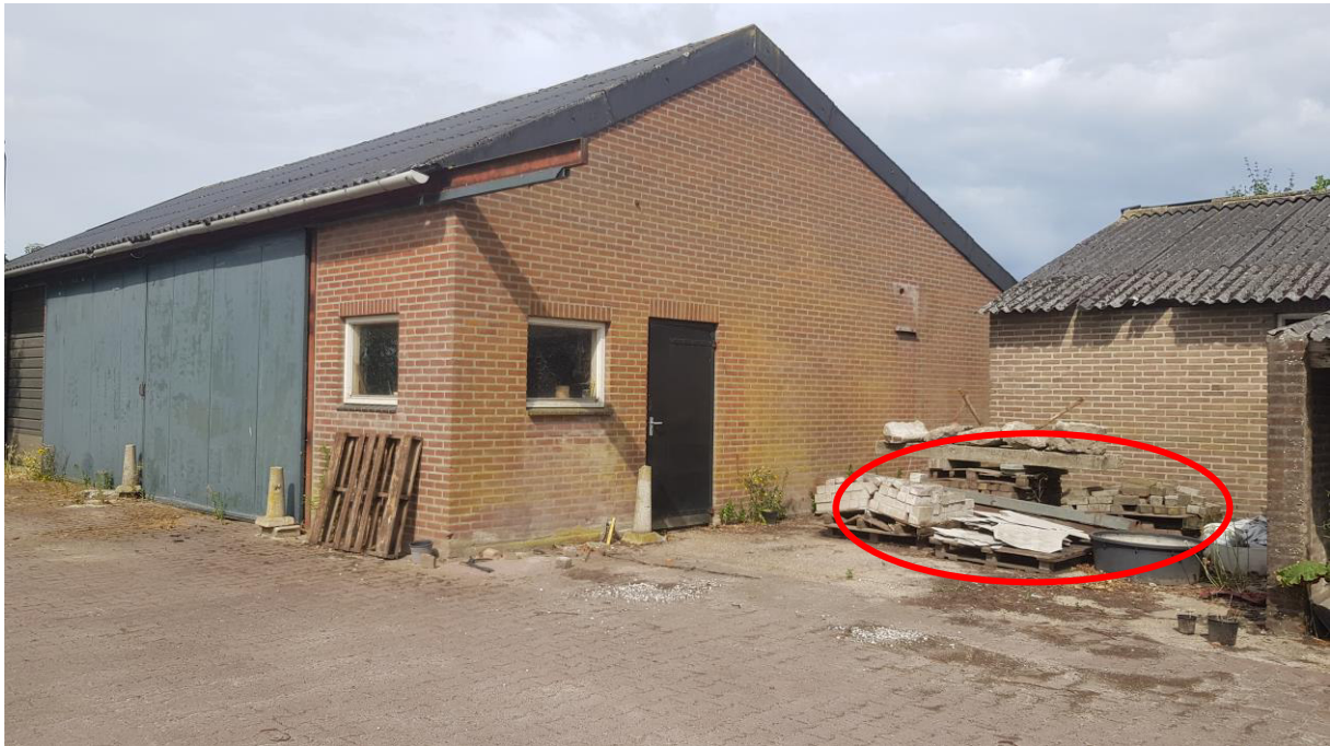
Locatie voormalige dieseltank
