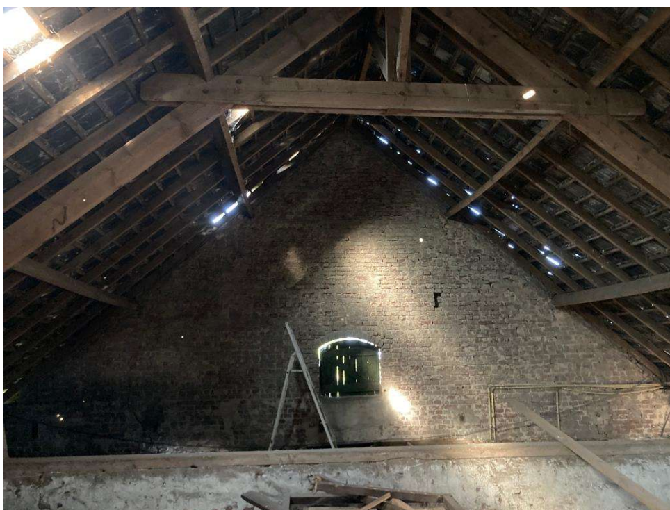
• Afbeelding 23: dakbeschoet te slopen schuur naast de woning
