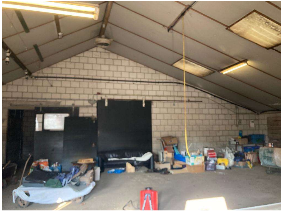
• Afbeelding 19: te slopen schuur
