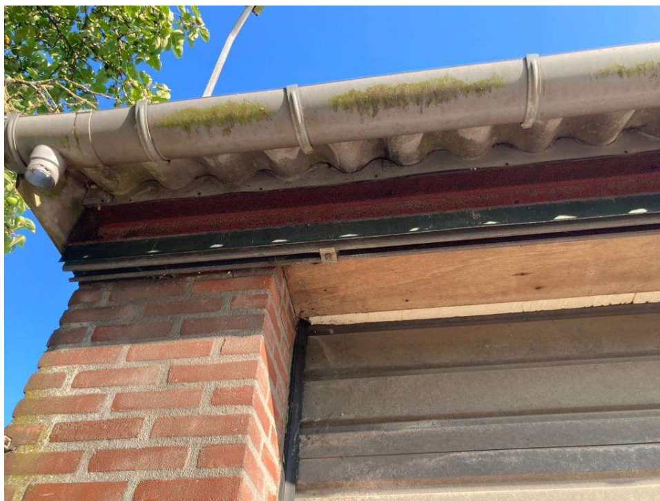
• Afbeelding 11: detail dakgoot loods
