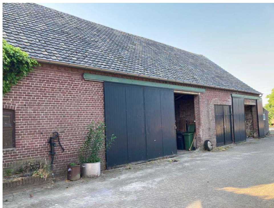
• Afbeelding 5: Bedrijfsgebouw links van de bedrijfswoning wordt gesloopt
