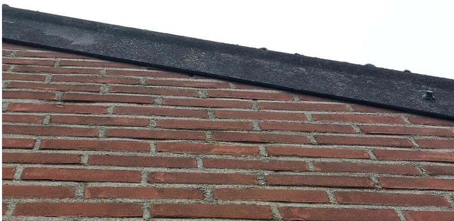
Figuur 4.2.3. De windveer op de kopgevel sluit nauw aan op de gevel.
