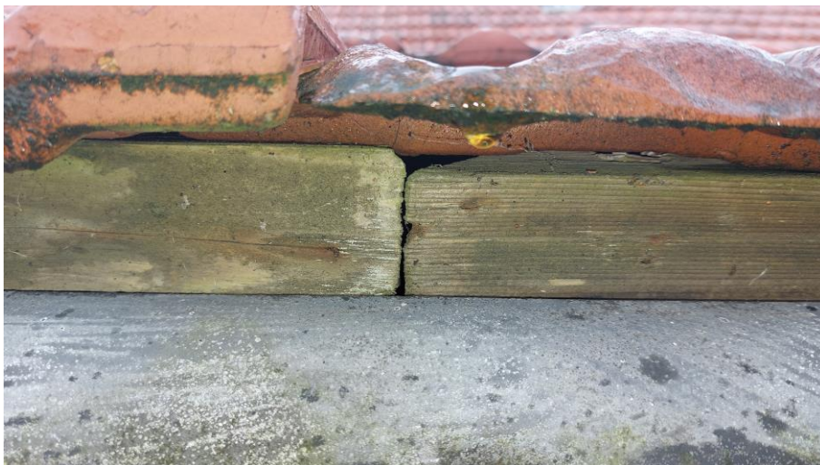
Figuur 4.2.3. De dakpannen liggen nauw op de pannenlat; vogels hebben hier geen toegang.
