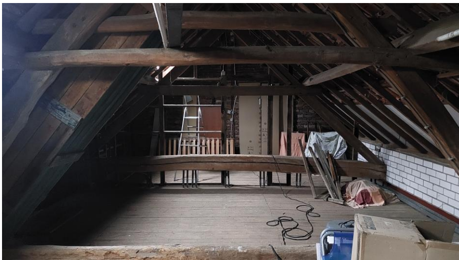
Figuur 4.2.5. De zolder is erg belicht en daardoor niet zeer geschikt als vleermuisverblijf; vleermuizen(uitwerpselen) zijn dan ook afwezig.
