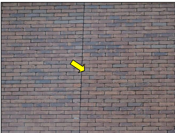
Figuur 12. Voorbeeld van dilatatievoeg aanwezig in de gevel van het huidige medisch centrum Wieënhof
