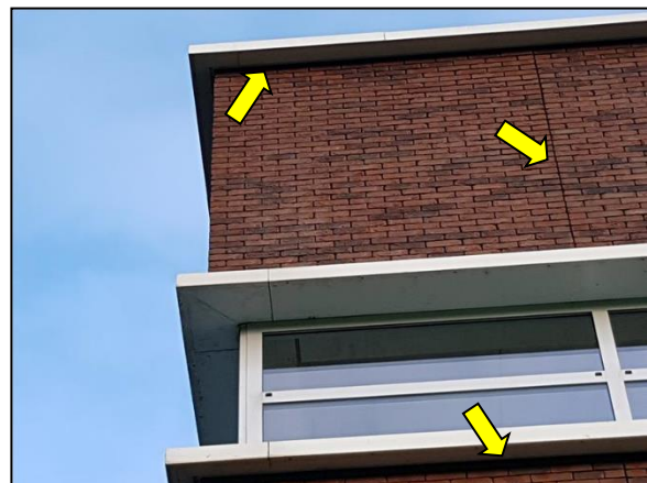
Figuur 13. Voorbeelden van dilatatievoeg en ruimtes onder dakranden van het huidige medisch centrum Wieënhof
