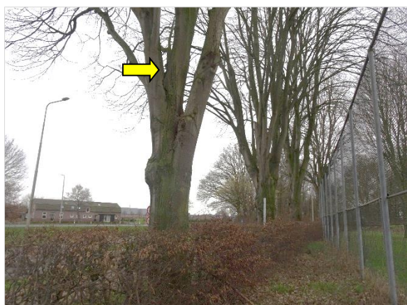
Figuur 10. Boom met holte in de bomenlaan (boom 4, figuur 20).
