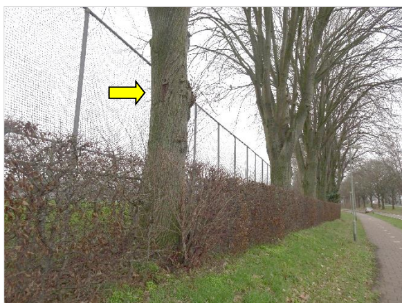
Figuur 6. Boom met scheur, bomenlaan (boom 2, figuur 20).
