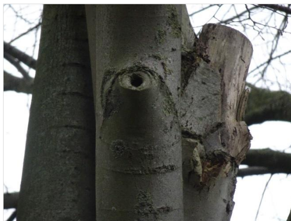
Figuur 9. Holte in boom (boom 3, figuur 20).
