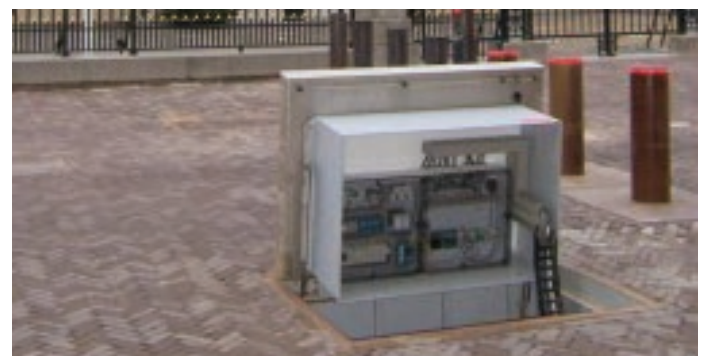
PUTkast (situatie boven maaiveld)
