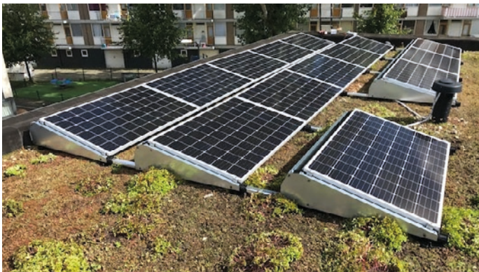
Groene daken in combinatie met zonnepanelen mogelijk en aanbevolen.
