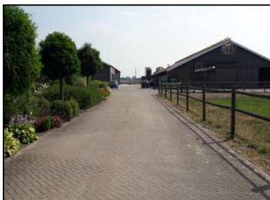
Figuur 5. Oprit woning Spurkt 5c binnen de onderzoekslocatie (datum foto: juli 2018).
