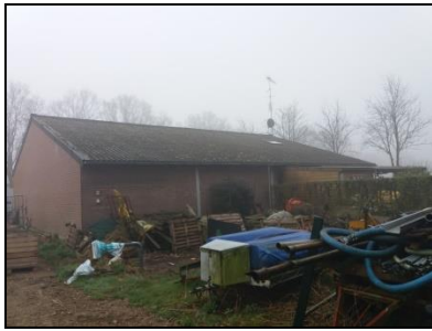
Figuur 2. Achterzijde woning Spurkt 8 binnen de onderzoekslocatie (datum foto: april 2018).
