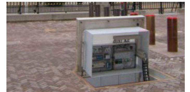
PUTkast (situatie boven maaiveld)
