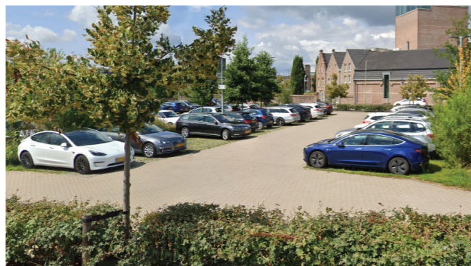
Parkeren op grasbetontegels in een groene setting. Om de parkeervakken een haagbeuk ter afscheiding
