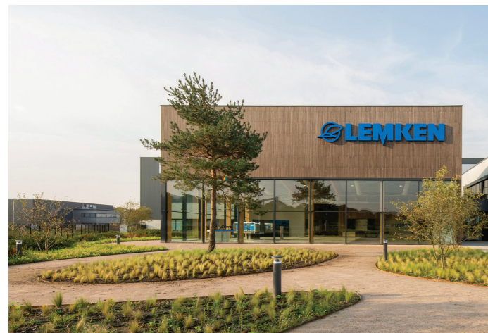
Representatieve zijde met groene inrichting, glas en houtafwerking. Kantoorfunctie aan de voorkant. (ref. Lemken Dinteloord - architect: Bolckmans)
