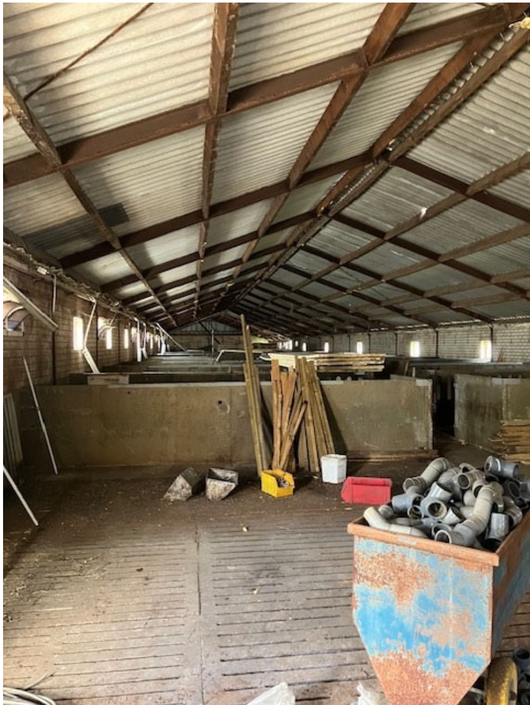
• Afbeelding 13: Binnenzijde te slopen varkensstal, ongeïsoleerd dak
