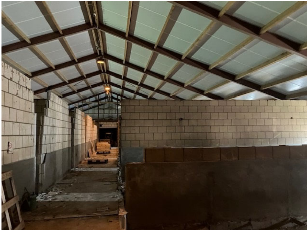
• Afbeelding 9: binnenzijde varkensstal, reeds begonnen met slopen
