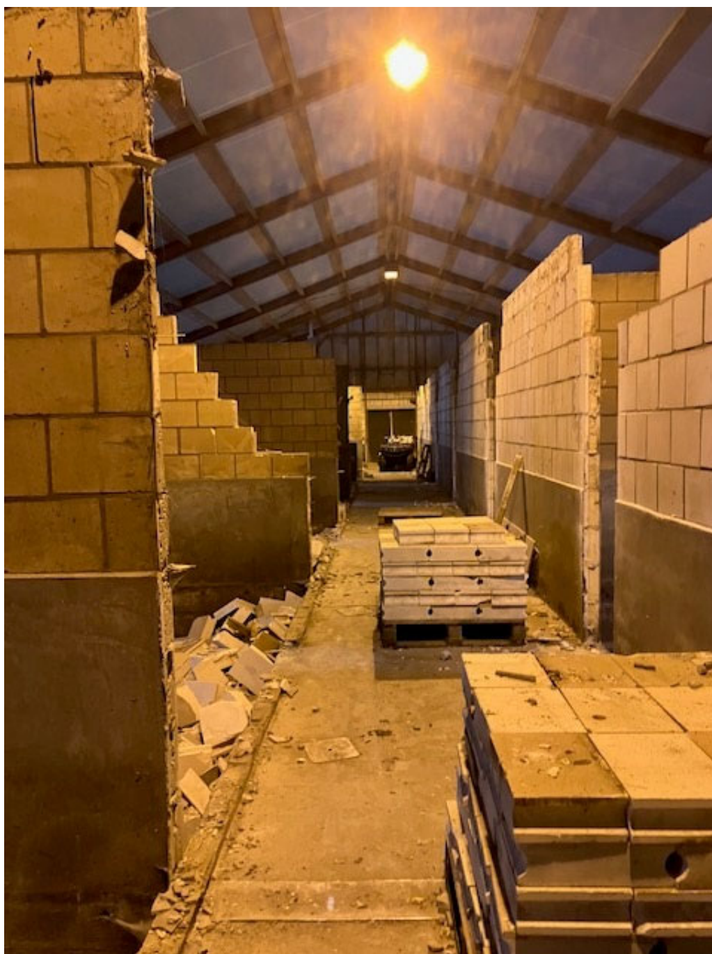
• Afbeelding 11: binnenzijde te slopen varkensstal
