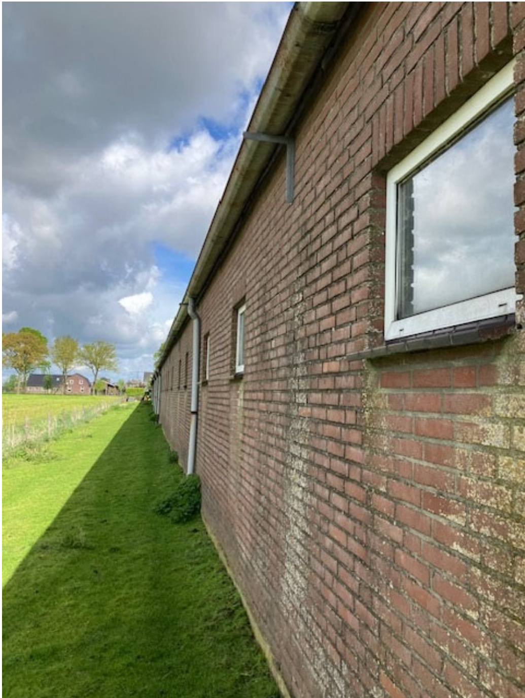
• Afbeelding 18: Buitengevel te slopen stal, geen oen stootvoegen of scheuren
