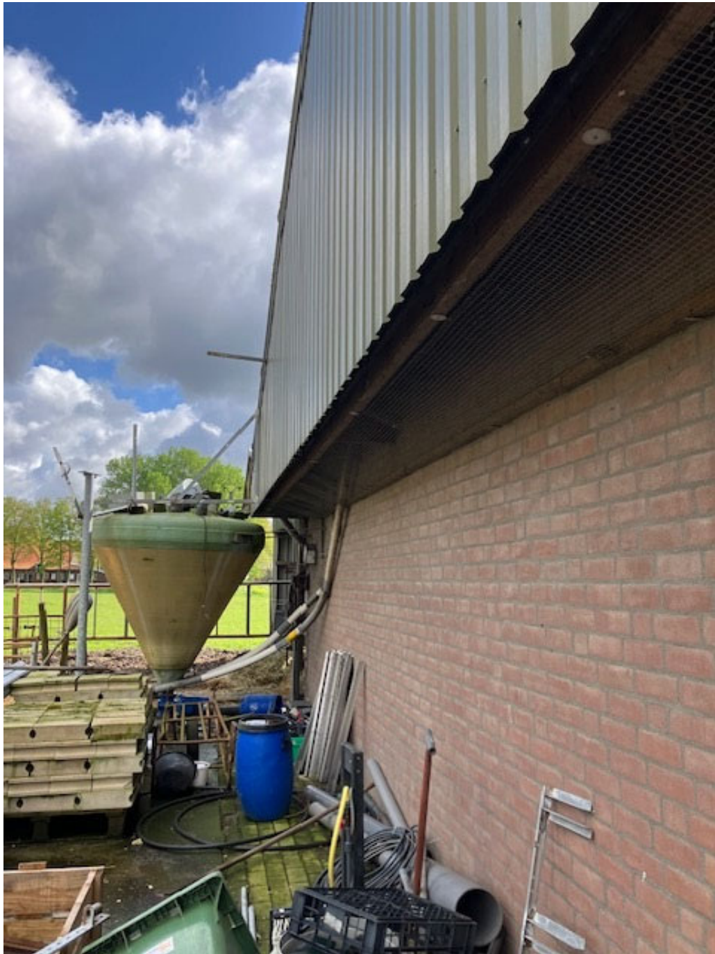
• Afbeelding 12: buitenzijde, luchtinlaat, aan onderzijde dichtgemaakt met gaas
