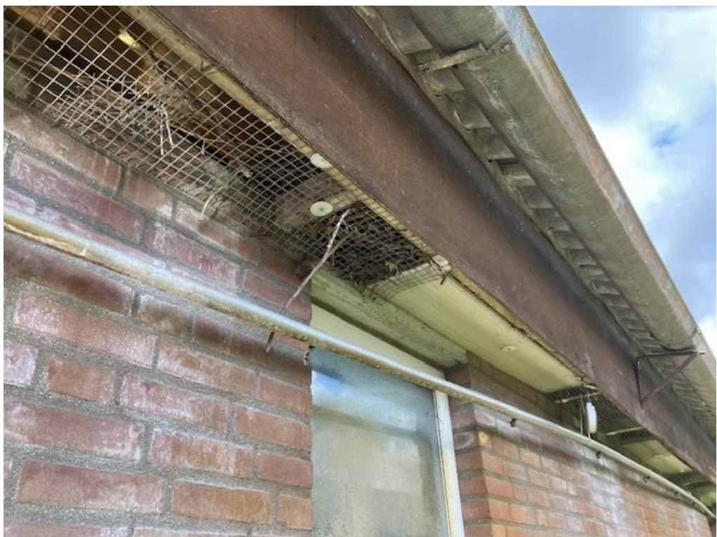
• Afbeelding 16: Onderzijde dak si afgewerkt met plaatmateriaal, onder het gaas zijn nesten van kauwen aanwezig
