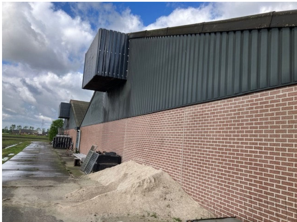
• Afbeelding 16: Achterzijde te slopen stallen
