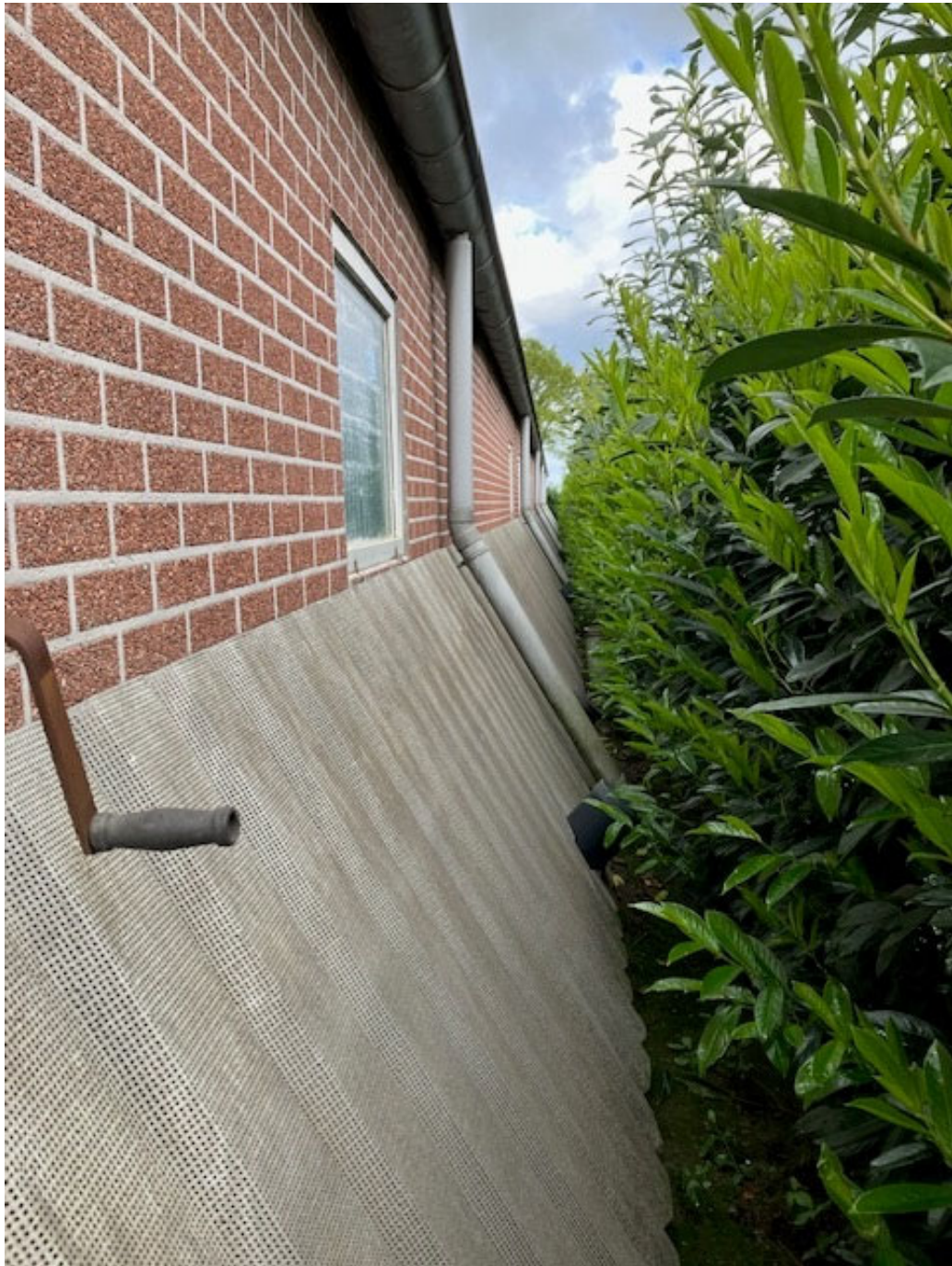
• Afbeelding 14: zijgevel van de te slopen stal
