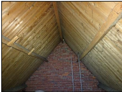
Figuur 23. Zolder met opening naar buiten toe.
