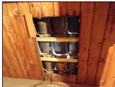
Figuur 15. Dakbeschot.
