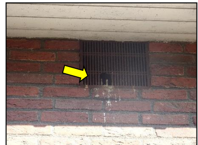
Figuur 16. Kapot rooster met krijtsporen.
