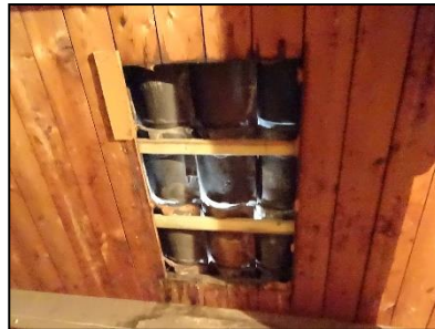
Figuur 24. Opening in het dakbeschot, toegang tot de zolder.
