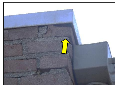
Figuur 22. Ruimte onder de daktrim van de basisschool.
