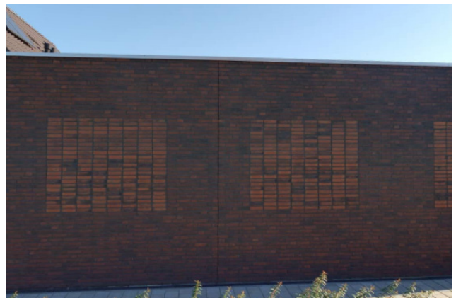
Figuur 24. Gevelaccenten in gevel gericht op openbare ruimte
