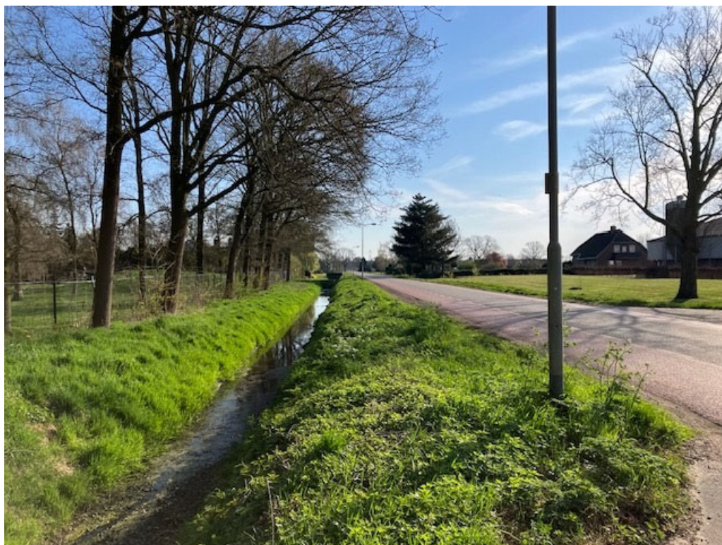
• Afbeelding 31: Straatbeeld in oostelijke richting
