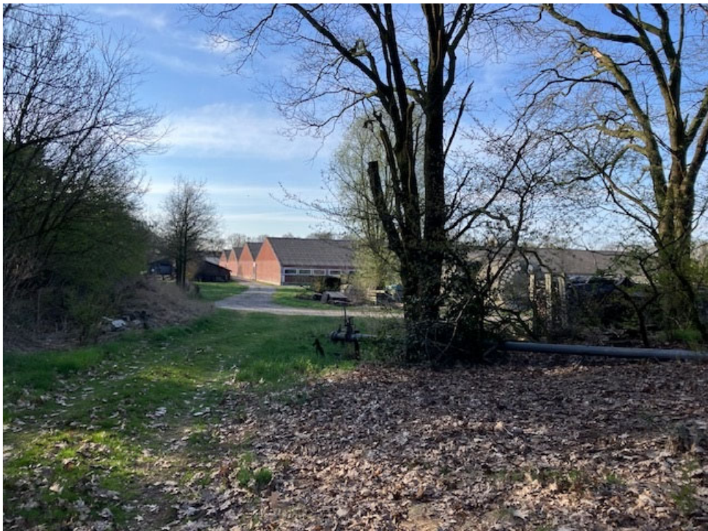
• Afbeelding 15: zicht op te slopen stallen vanaf de mestzak, bomen op voorgrond worden gerooid
