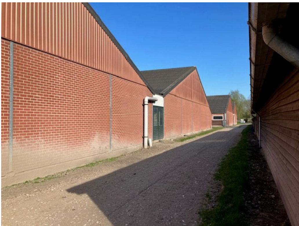
• Afbeelding 24: erf tussen de te slopen stallen
