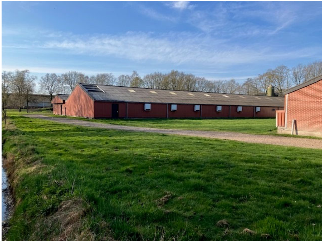
• Afbeelding 23: te slopen stallen
