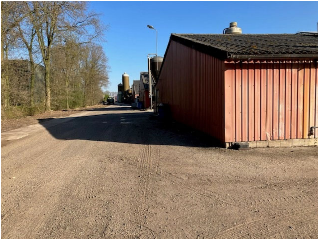
• Afbeelding 4: zicht op de te slopen stallen. De houtwal links blijft behouden
