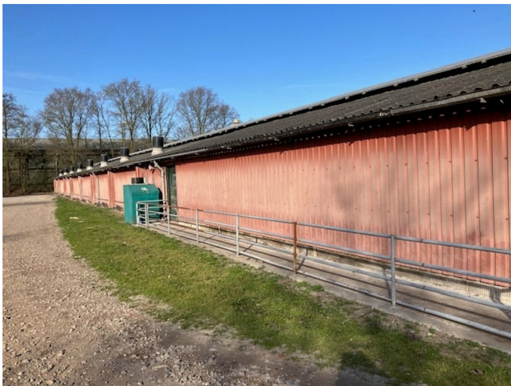
• Afbeelding 27: te slopen stal
