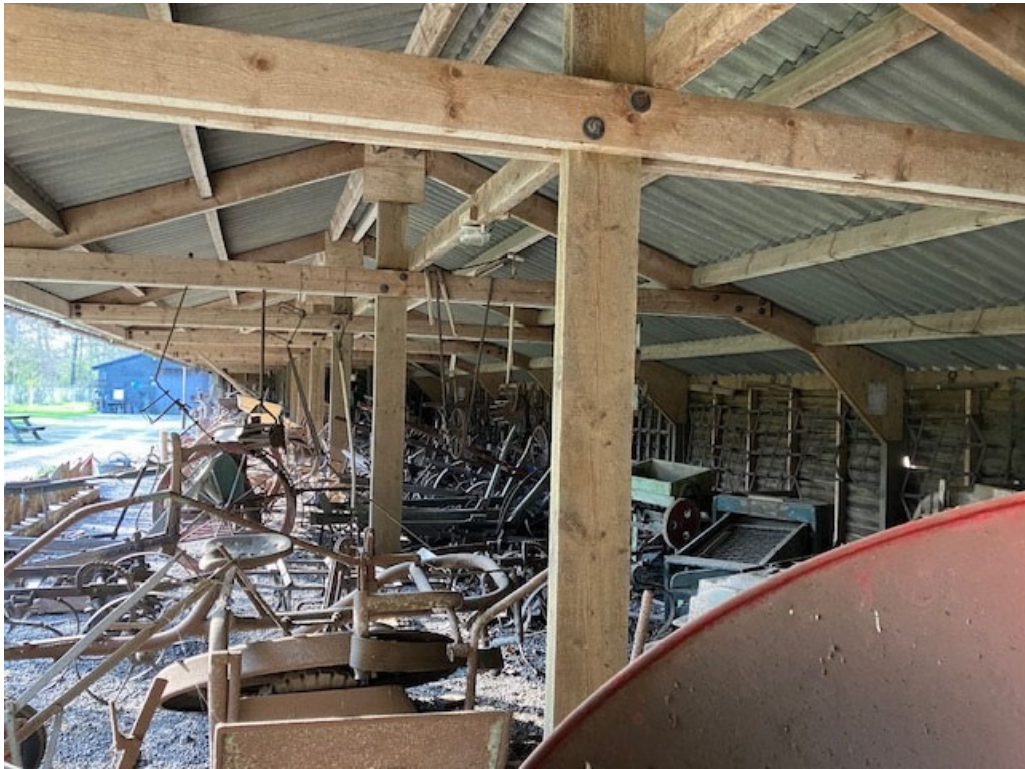
• Afbeelding 18: binnenzijde te slopen open veldschuur
