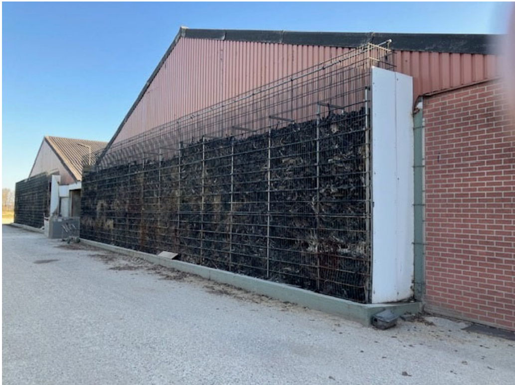
• Afbeelding 10: luchtwassers aan het eind van de stallen
