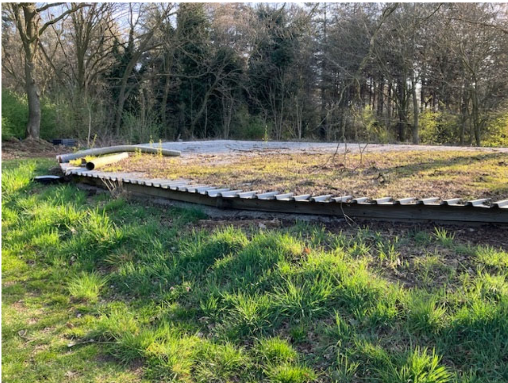
• Afbeelding 13: mestzak met daarop damwand, wordt verwijderd
