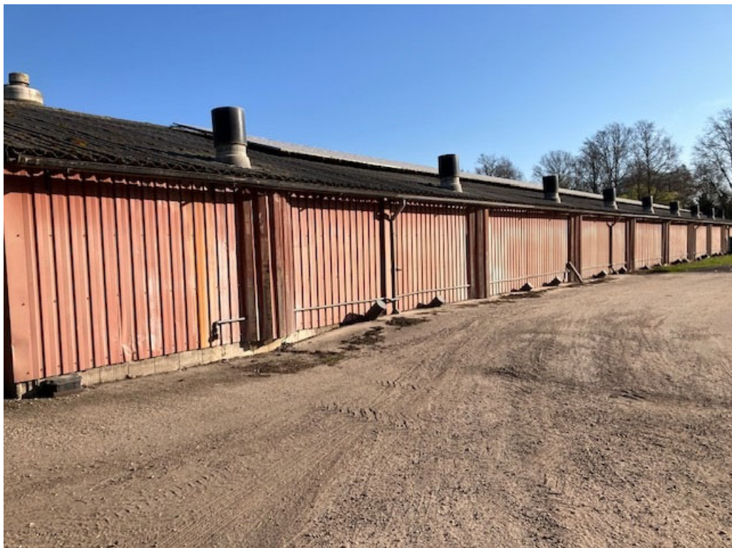
• Afbeelding 5: te slopen stal
