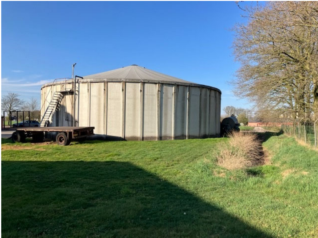
• Afbeelding 20: Mestsilo wordt gesloopt
