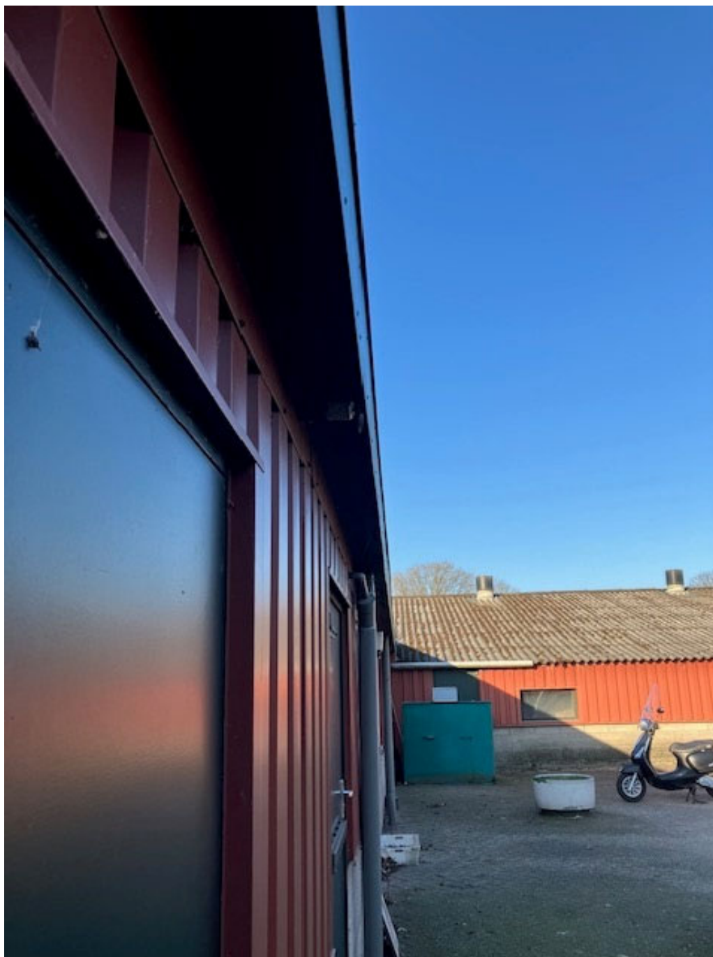
• Afbeelding 13: onderzijde dak
