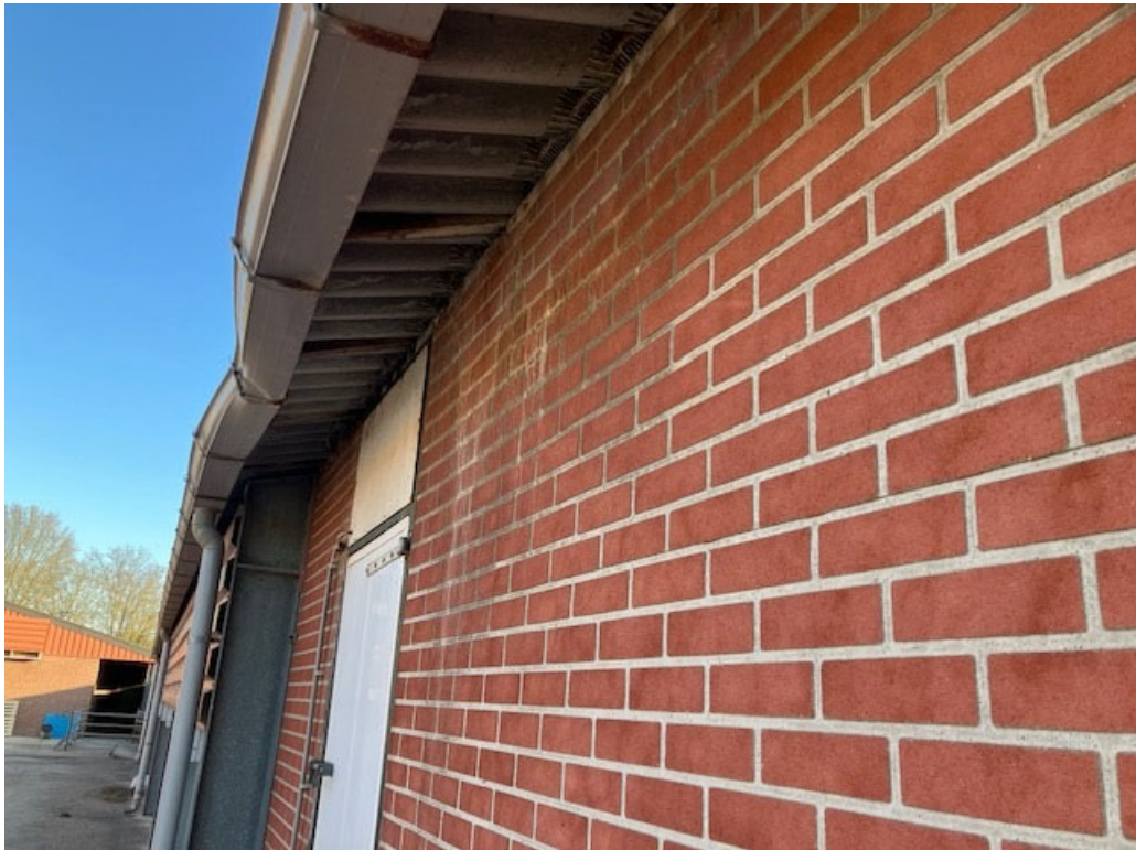
• Afbeelding 21: onderzijde dak, gevel van prefab metselwerk
