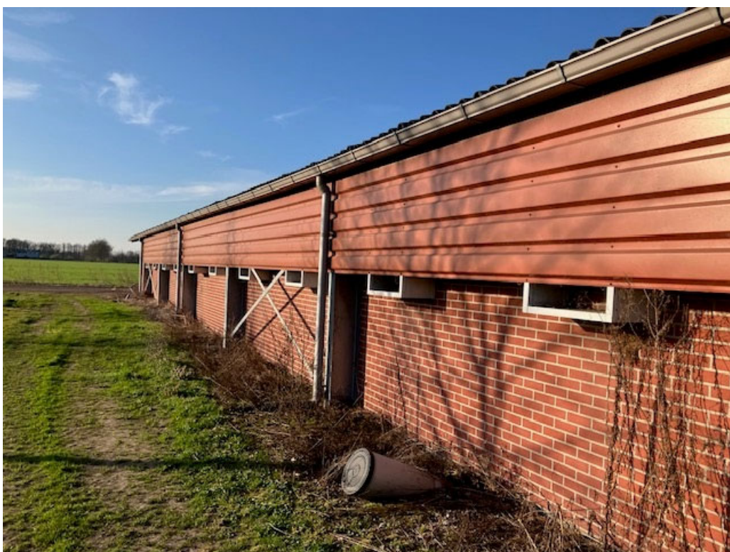
• Afbeelding 17: zijgevel te slopen stallen met aangrenzend grasland
