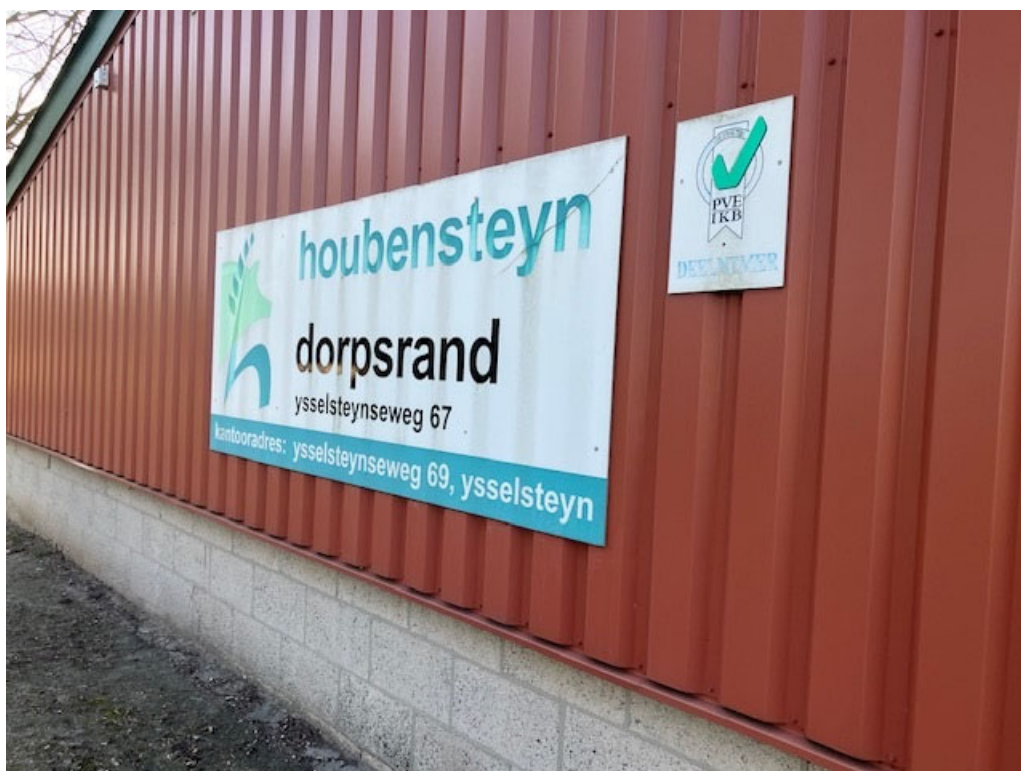
• Afbeelding 11: voorgevel met damwand bekleed
