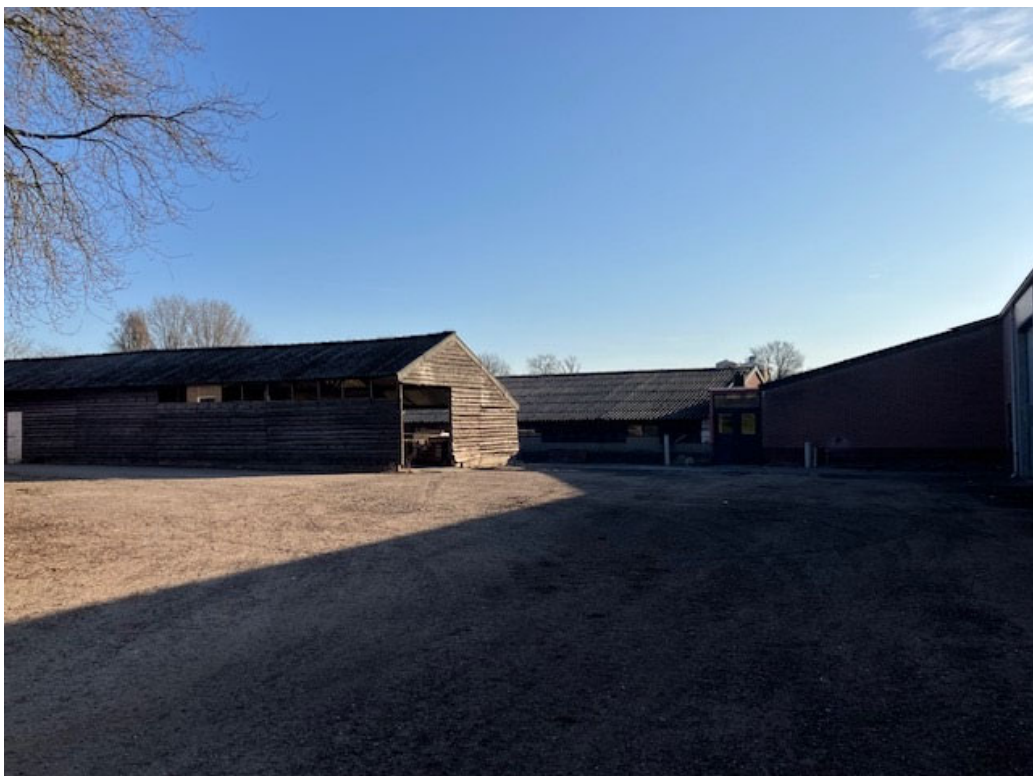
• Afbeelding 34: Te slopen stallen
