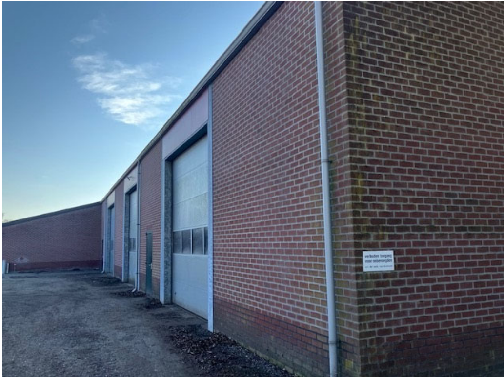
• Afbeelding 33: Deze schuur wordt gesloopt
