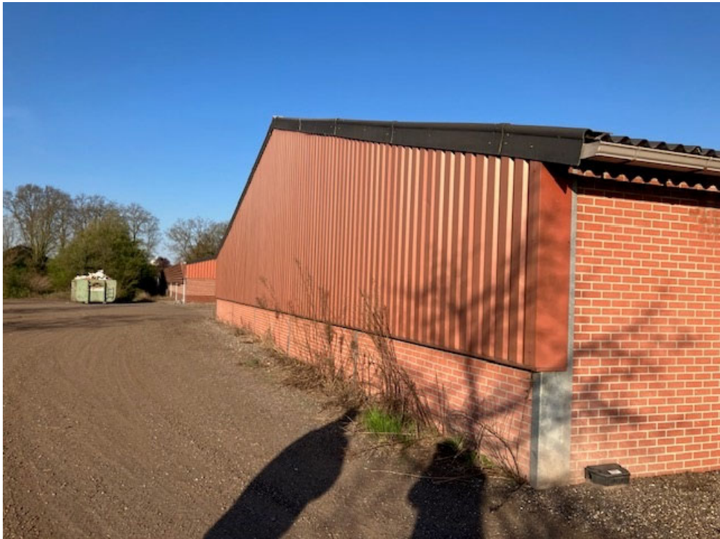
• Afbeelding 19: Achtergevel te slopen stal met aangrenzend erf van semiverharding
