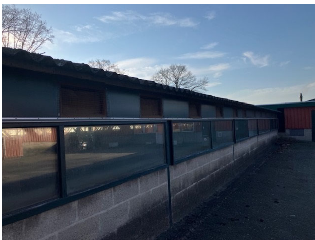
• Afbeelding 12: zijgevel te slopen stal
