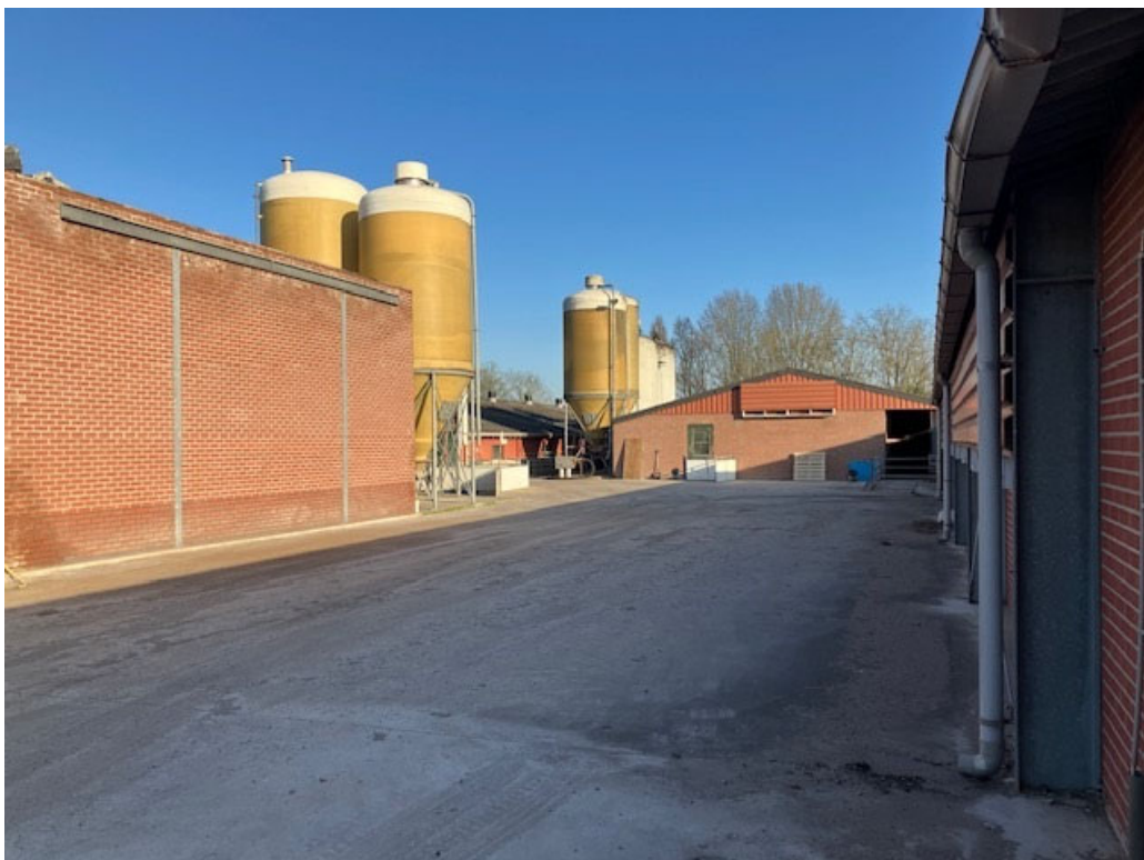
• Afbeelding 22: Te slopen stallen
