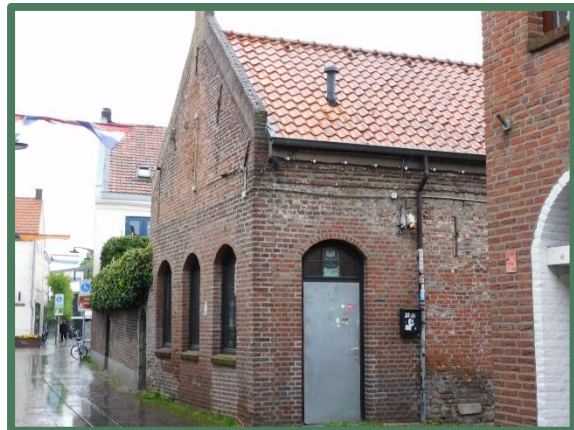
Foto 6: Noordwestzijde gebouw (plangebied).
