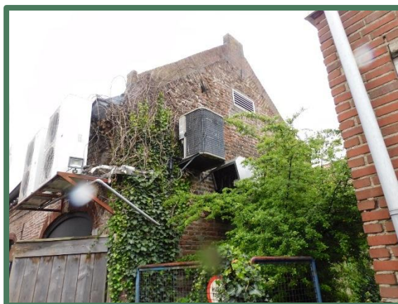
Foto 10: Zuidzijde gebouw (plangebied).
