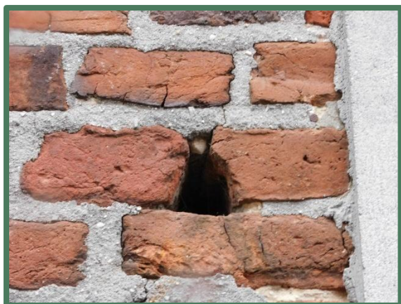
Foto 3: Opening in de gevel.
