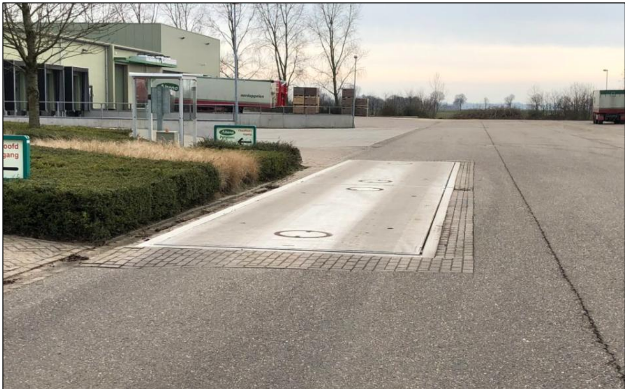
Afbeelding 14. Voorbeeld van een weegbrug welke een onderdeel vormt van de erfverharding
