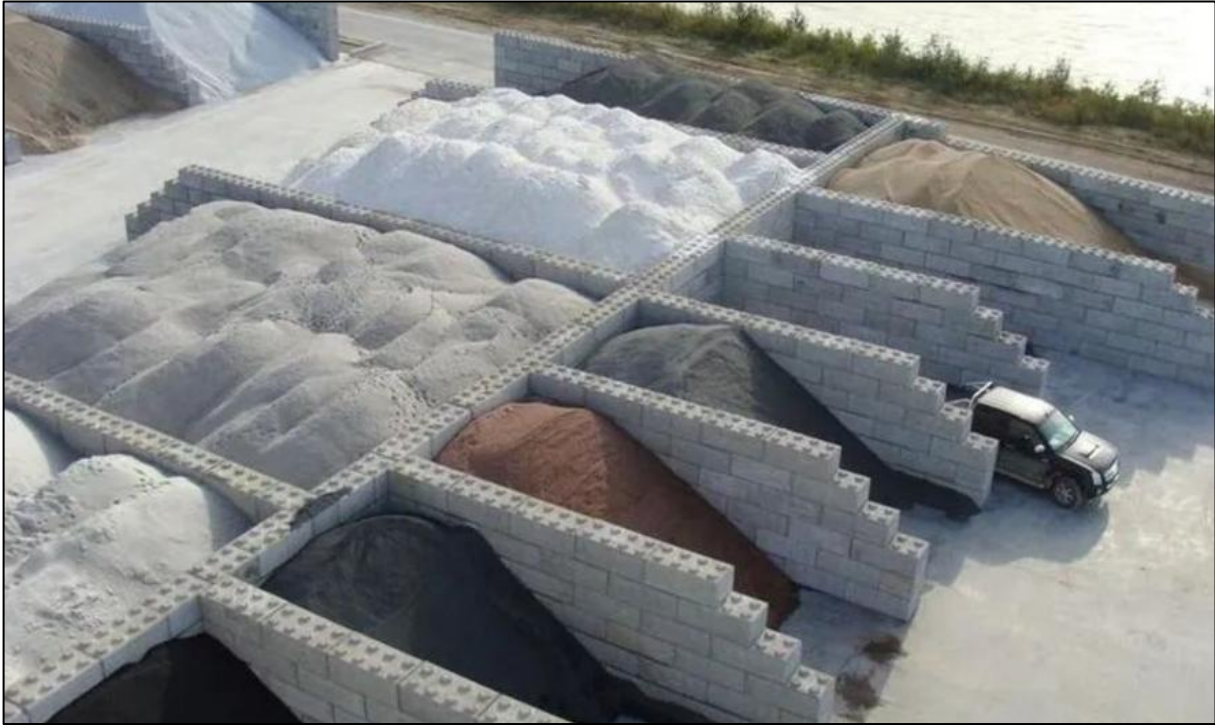
Afbeelding 13. Voorbeeld opslag producten van elkaar gescheiden door keerwanden
