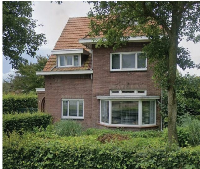
Verspringing in gevel, dorpel, dakkapellen
