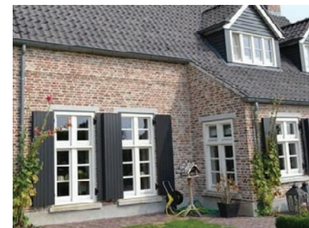
Detail in kozijnen met luiken en afwijkende plint
