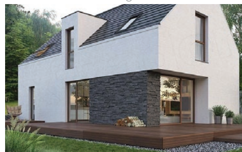
Verbijzondering in metselwerk
