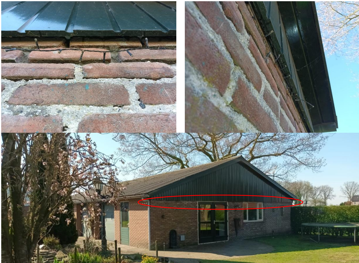
Figuur 8, Boven – gevelbekleding biedt geen toegang tot in de schuur en zijn goed met een zaklamp te overzien. Foto onder is de locatie van mogelijke opening.
