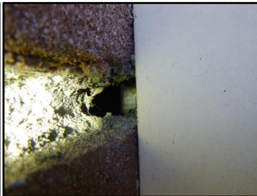
Spouwaansluiting ter plaatse van de gevelkozijnen is niet asbestverdacht.
