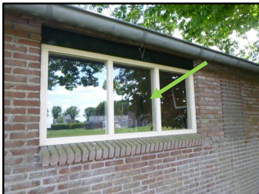
M2 – beglazingskit gevelkozijnen is niet asbesthoudend.
