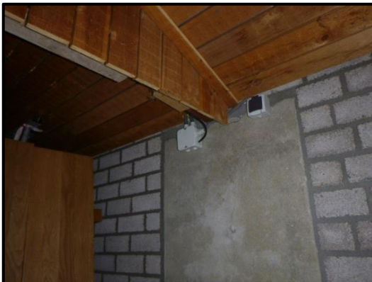
Binnenwanden en dakafwerking binnenzijde is niet asbestverdacht.
