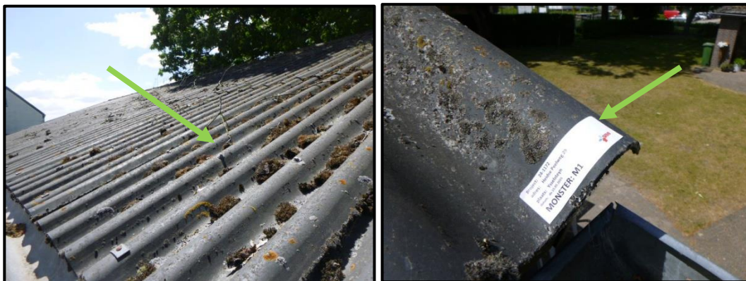
M1 – golfplaat hoofddak schuur niet asbesthoudend.
