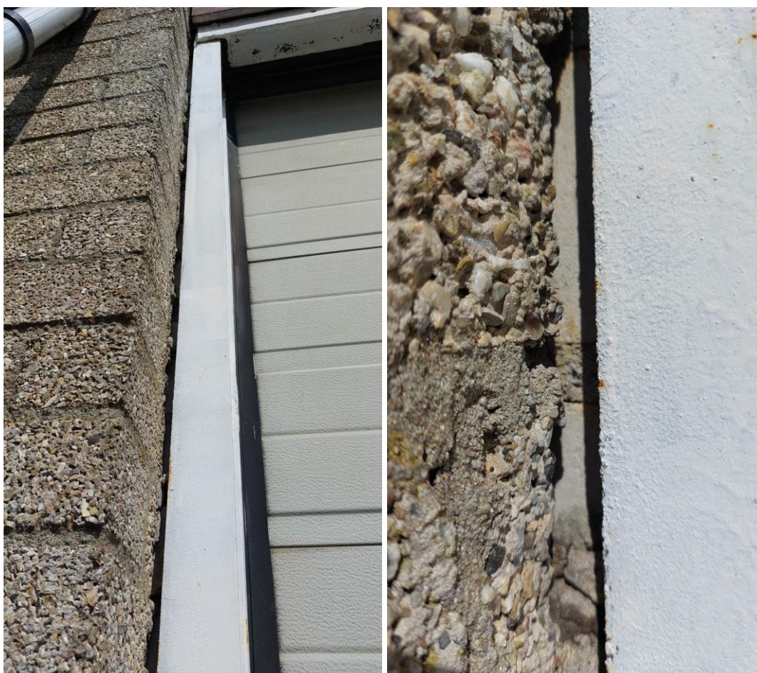
Figuur 4.4.7. Zichtbare spouw aan de achterzijde.
