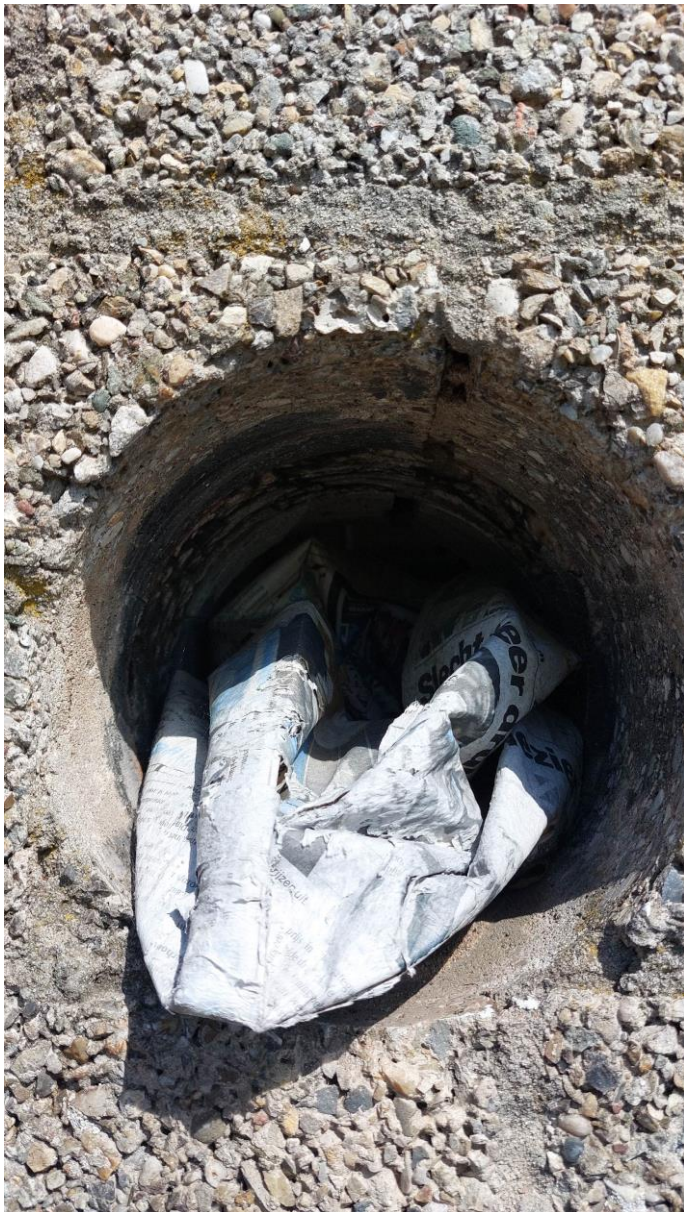
Figuur 4.4.5. Gat in de muur met spouwtoegang.
