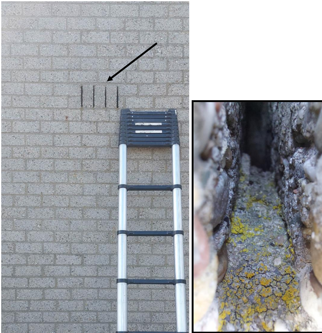
Figuur 4.4.3. Ventilatiesleuven.
