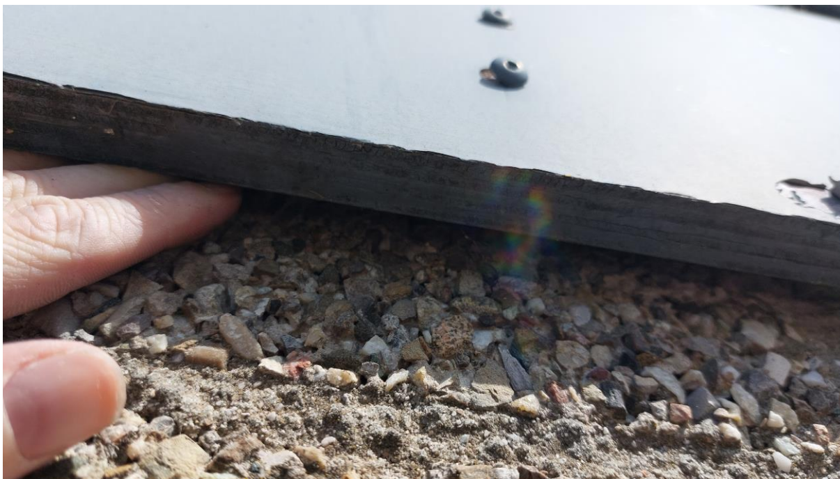
Figuur 4.4.6. Het boeiboord kiert met de gevel.
