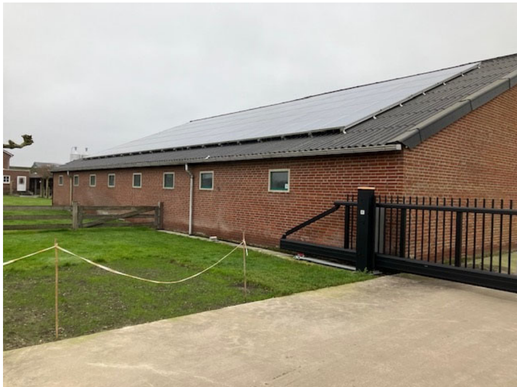
• Afbeelding 4: schuur aan de straatzijde (blijft behouden)
