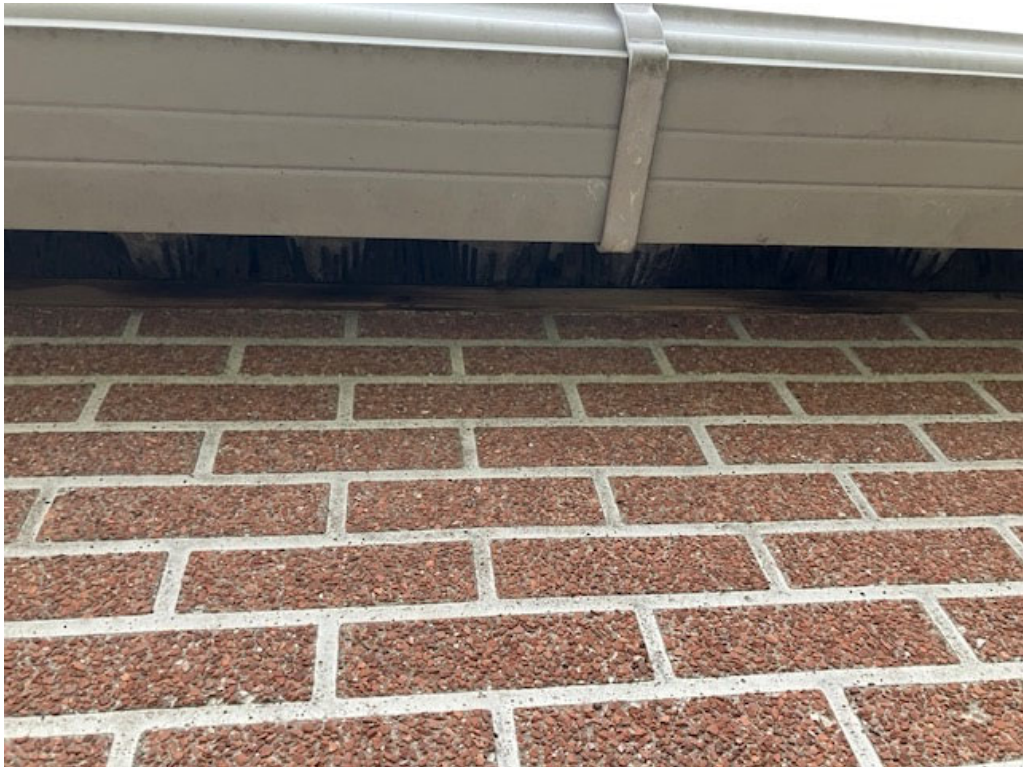
• Afbeelding 7: dakaansluiting, muurplaat voorzien van vogelschroot
