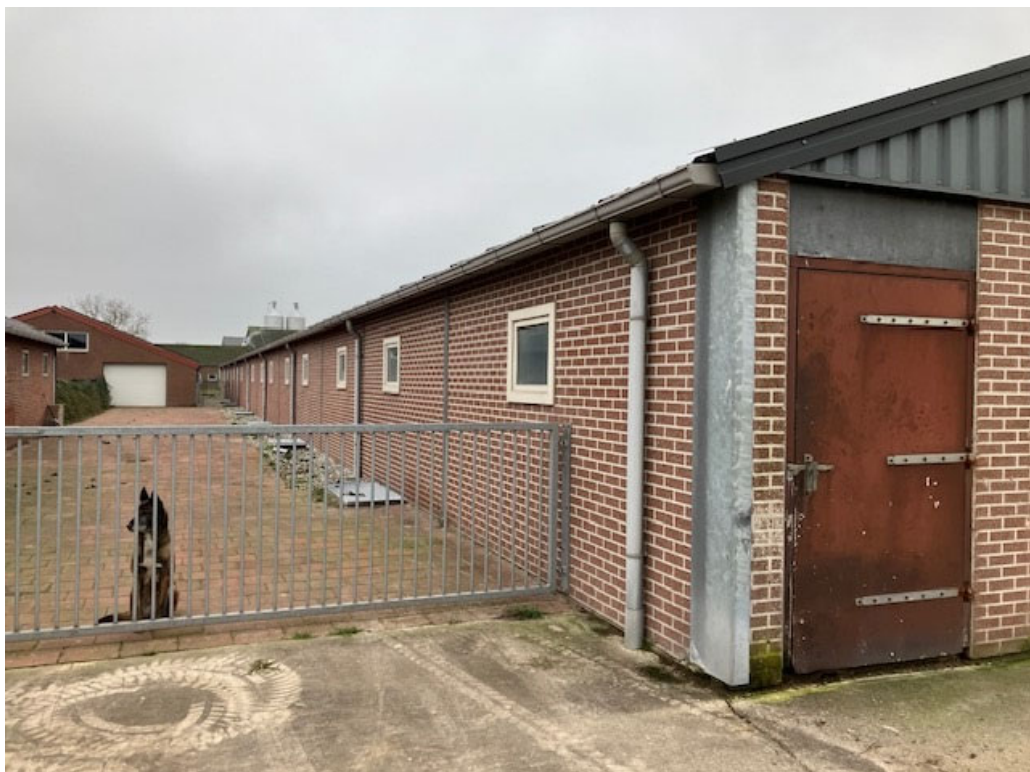
• Afbeelding 6: te slopen varkensstallen
