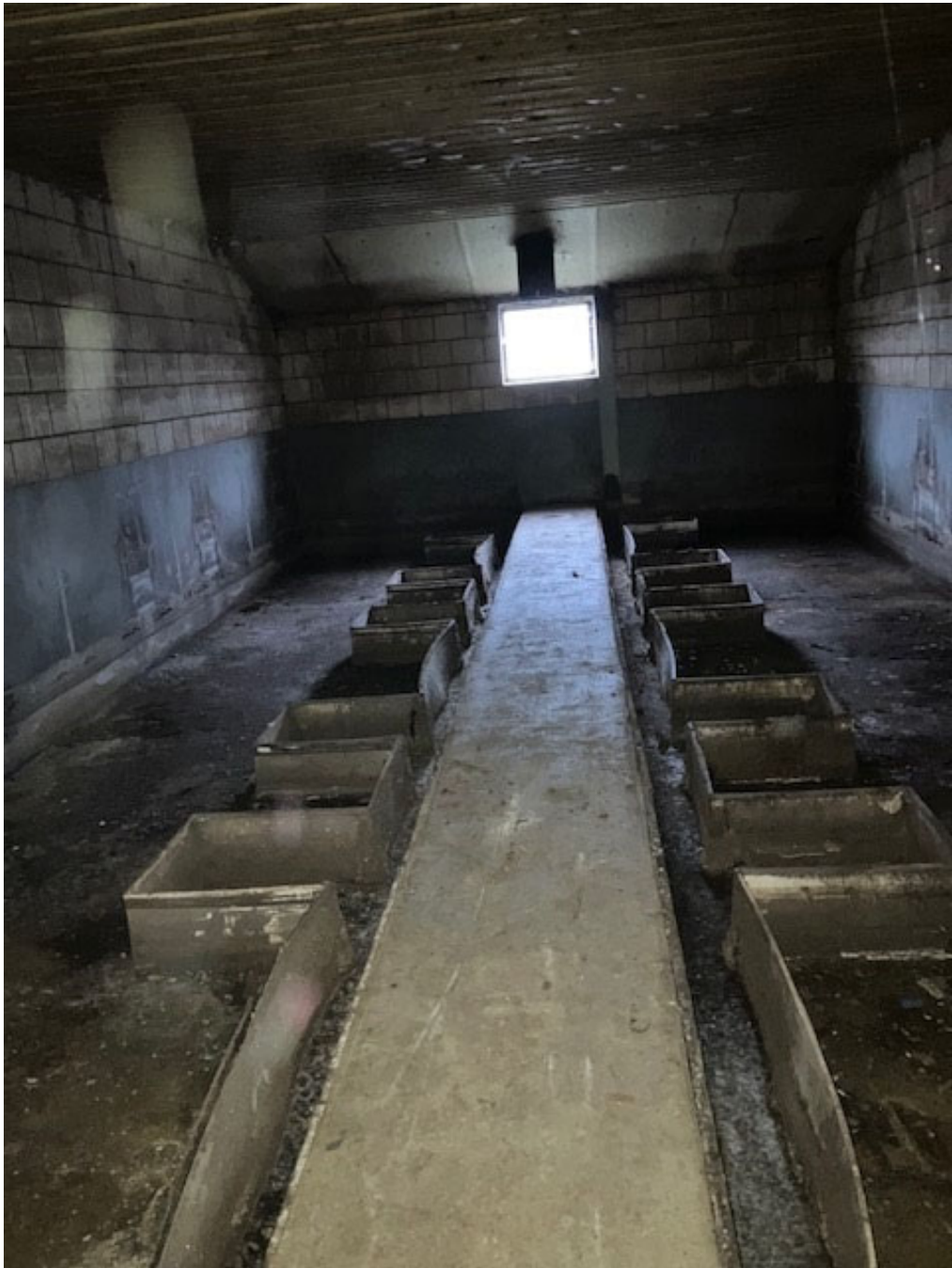
• Afbeelding 16: binnenzijde voormalige kraamhokken
