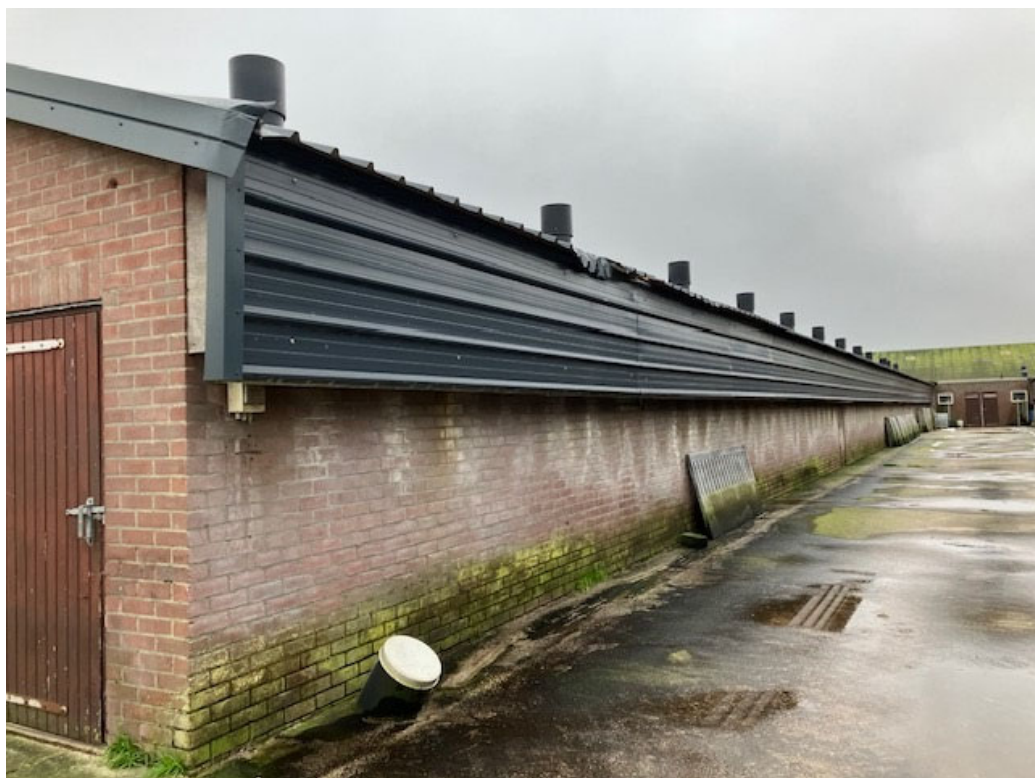
• Afbeelding 8: rechter zijgevel te slopen vleesvarkensstal
