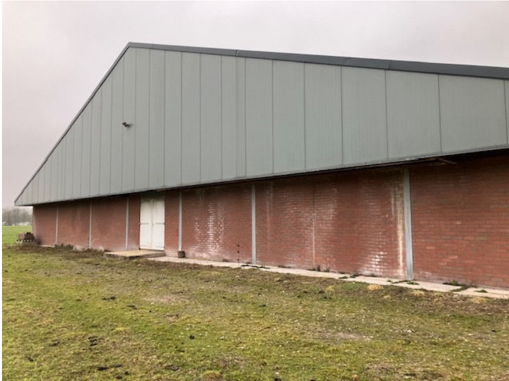
• Afbeelding 14: achtergevel te slopen varkensstal (achterste stal)
