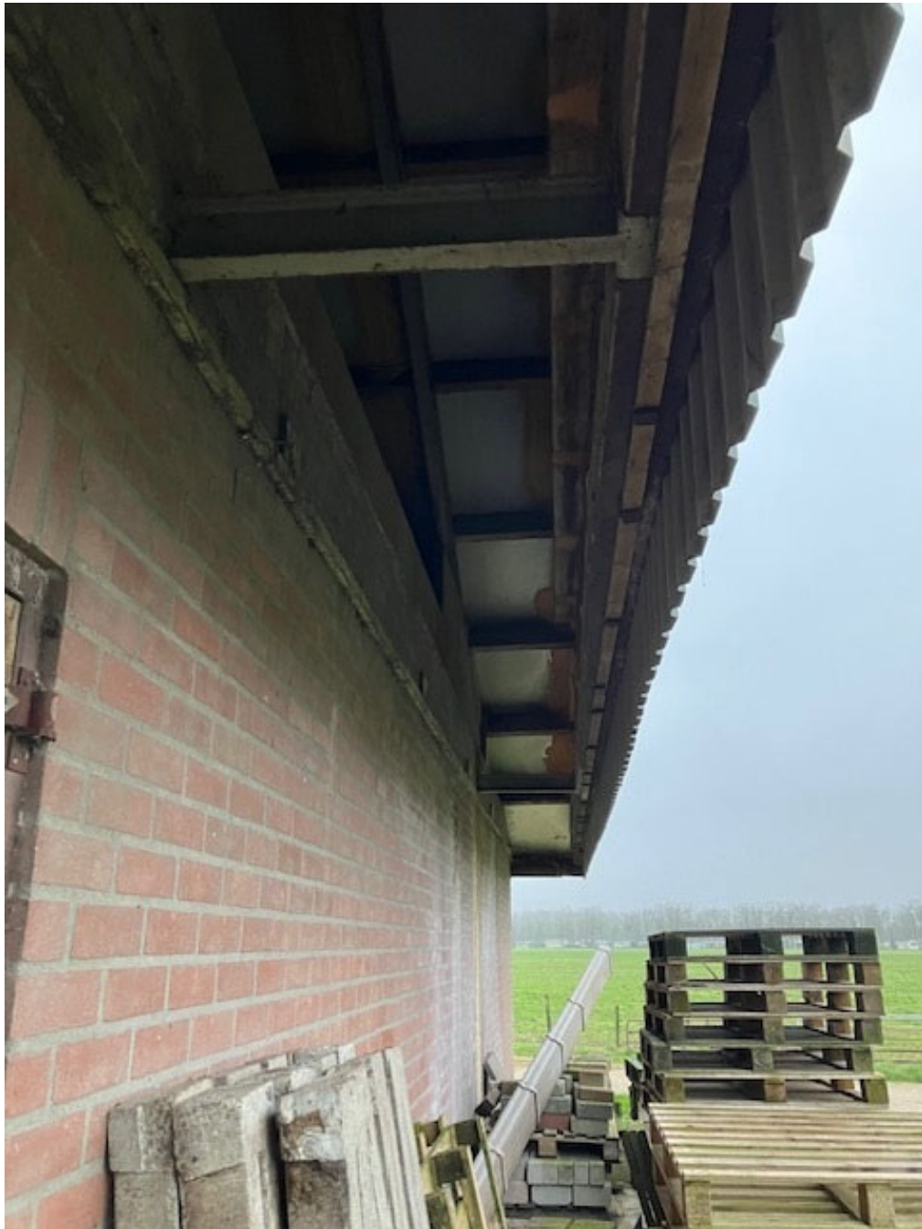
• Afbeelding 11: lucht inlaat onder de overstek bij de achtergevel
