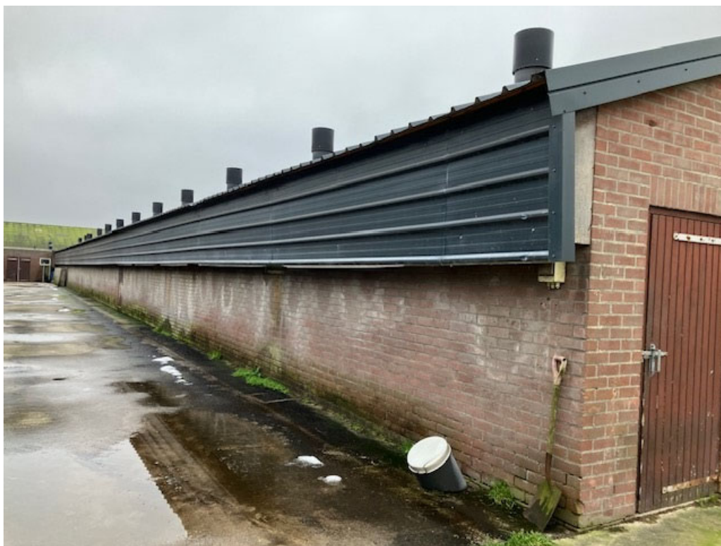
• Afbeelding 9: linker zijgevel te slopen vleesvarkensstal
