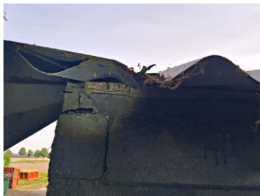
Figuur 17: Ruimte tussen dak en isolatie
