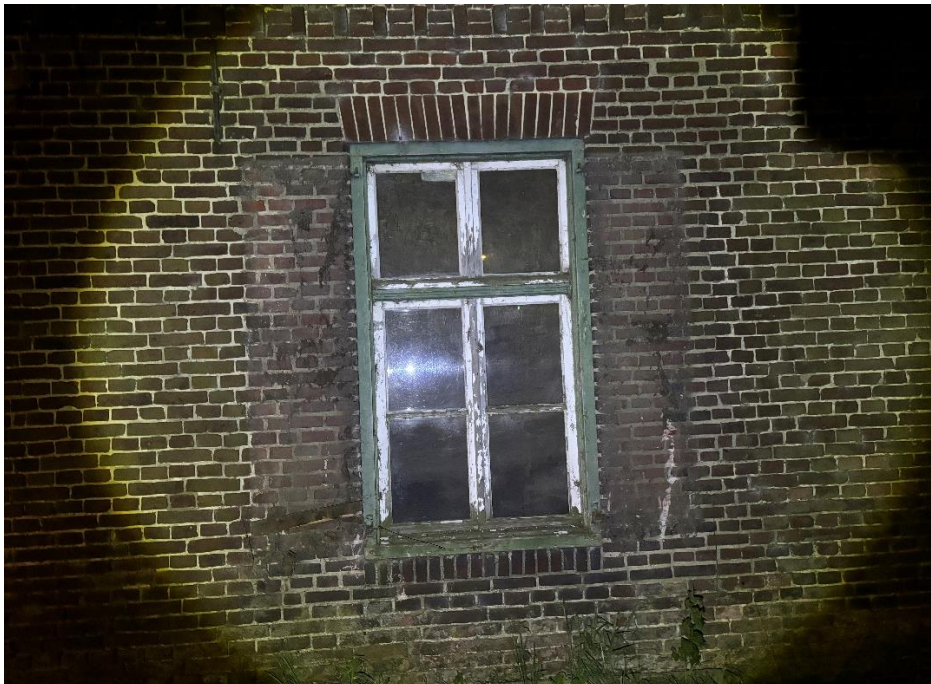
Figuur 2: Uit voorzorg zijn beide raamluiken bij het meest oostelijke raam aan de noordzijde van de woning verwijderd. Ook bij het westelijke raam aan deze zijde zijn de raamluiken uit voorzorg verwijderd.
