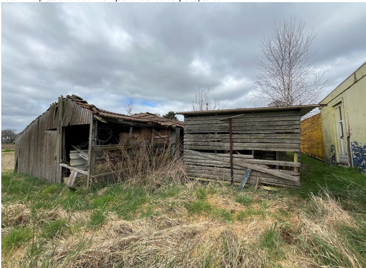
Foto 18: De zuidelijke kapschuur kijkend naar de oost- en zuidgevels.
