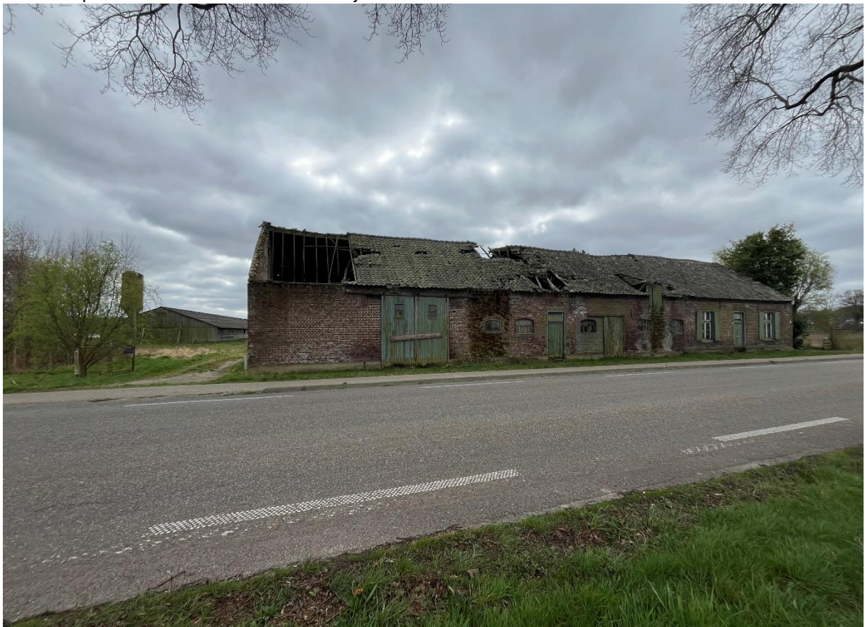
Foto 2: De bedrijfswoning kijkend naar de noordgevel.
