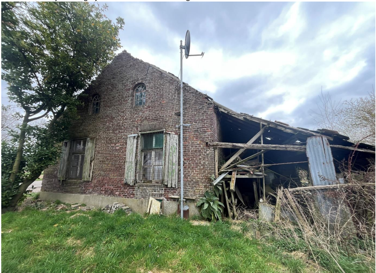
Foto 4: De bedrijfswoning kijkend naar de westgevel.
