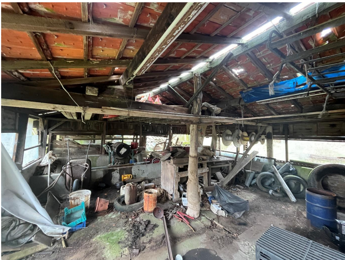
Foto 17: Impressie van de binnenzijde van de noordelijke kapschuur.
