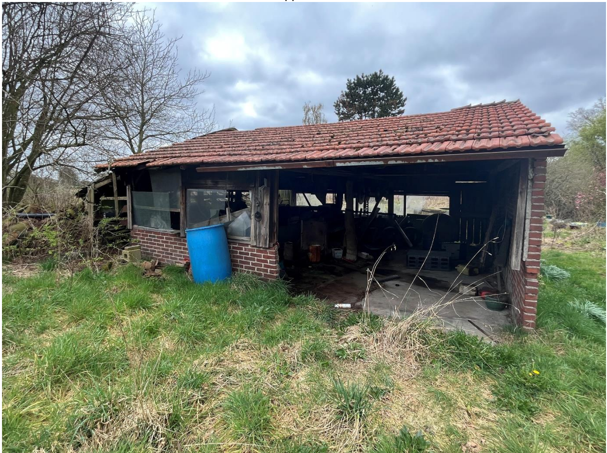
Foto 16: De noordelijke kapschuur op de onderzoekslocatie.
