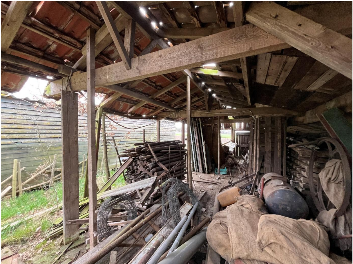
Foto 19: Impressie van de binnenzijde van de zuidelijke kapschuur.
