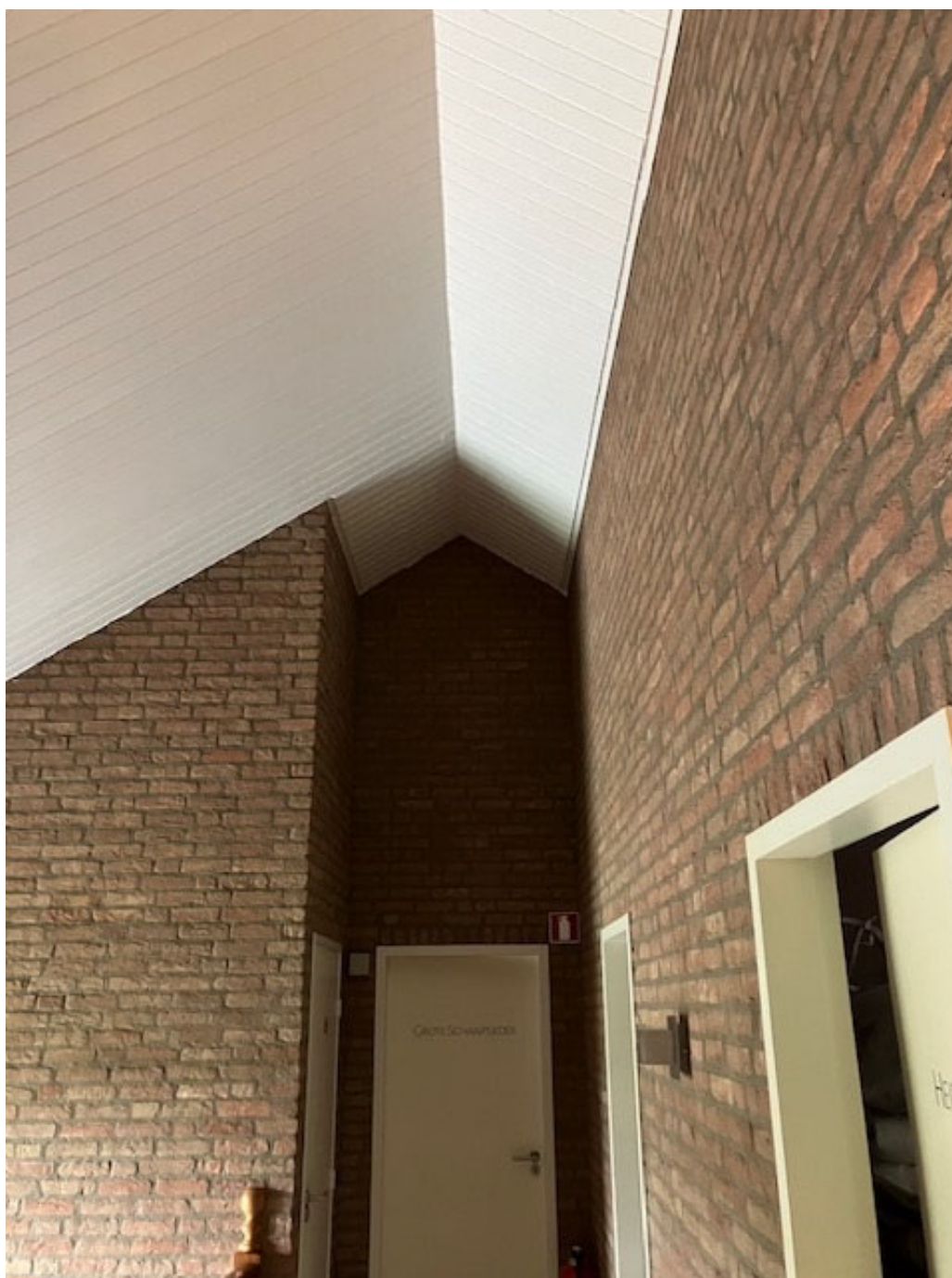
• Afbeelding 17: Binnenzijde, top van het dak
