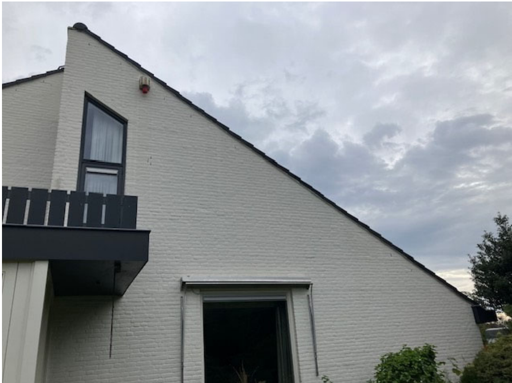
• Afbeelding 13: De open stootvoegen zijn smal en dicht gemaakt
