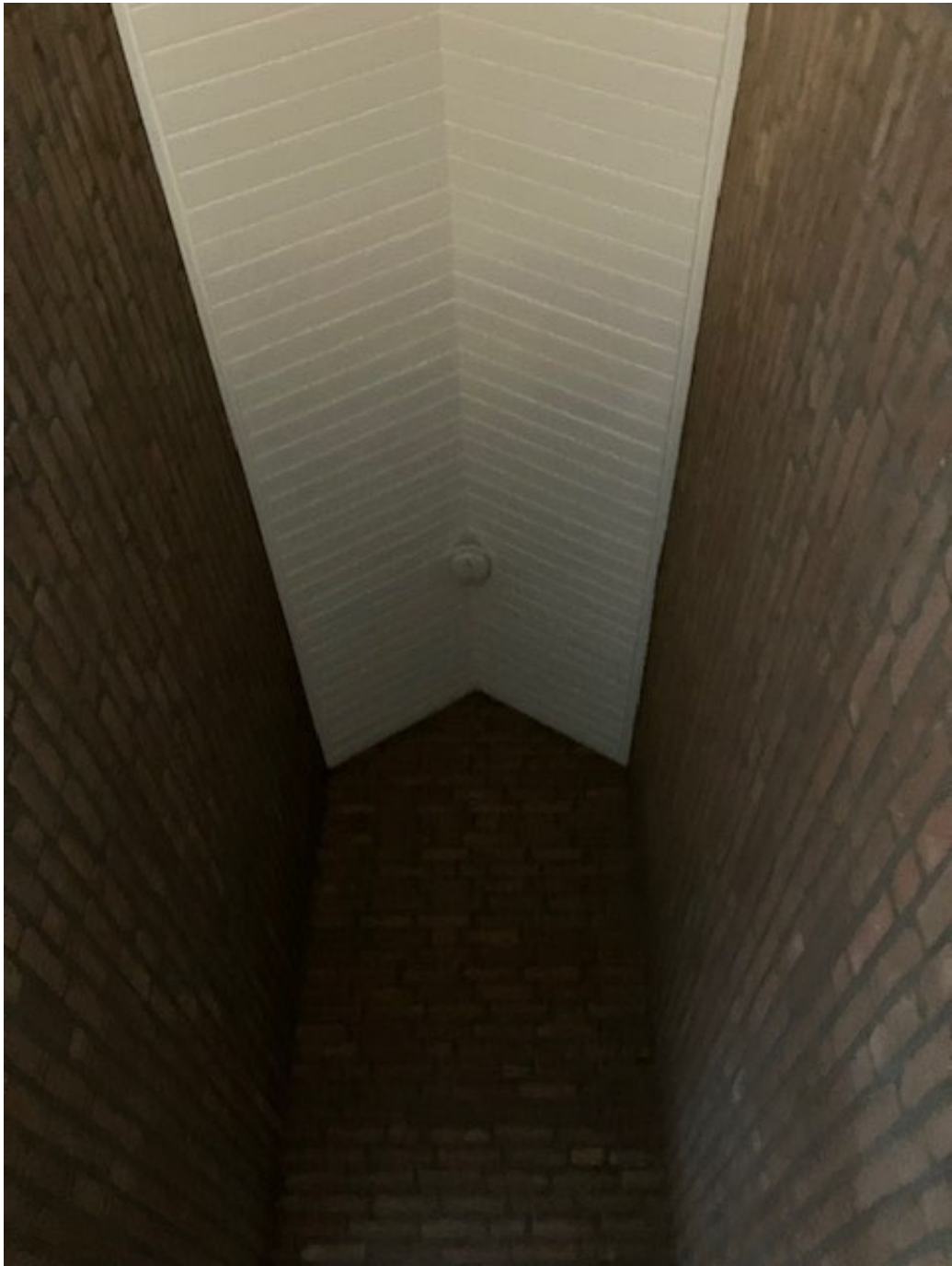
• Afbeelding 18: Binnenzijde, top van het dak
