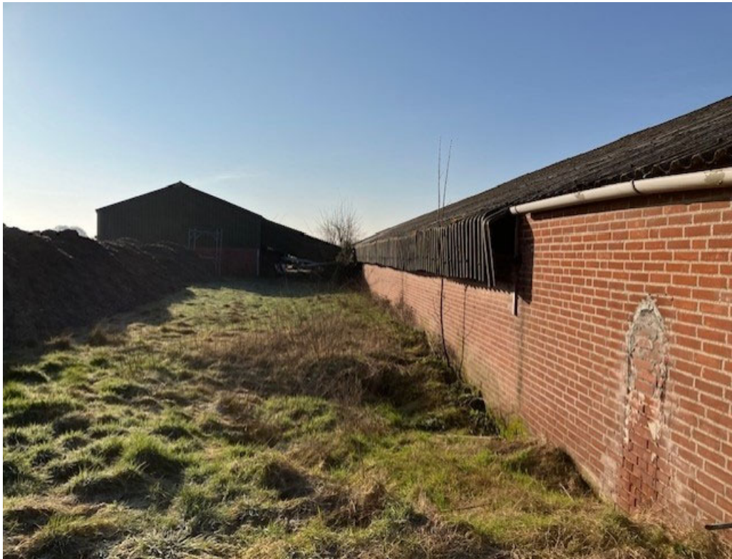
• Afbeelding 9: zijgevel te slopen varkensstallen
