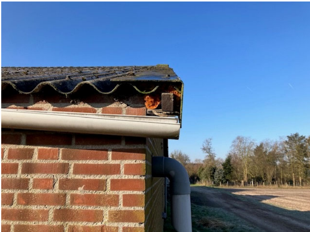
• Afbeelding 10: Alles is dicht gepurd
