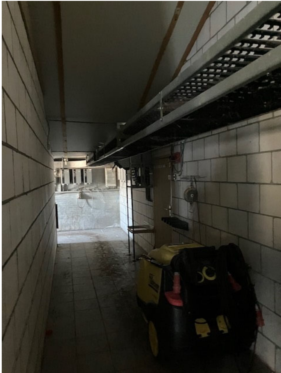
• Afbeelding 20: Centrale gang in de pluimveestallen
