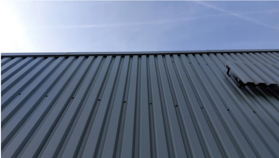
Figuur 4.2.1. Vleermuizen hebben nergens grip op de damwandplaten.
