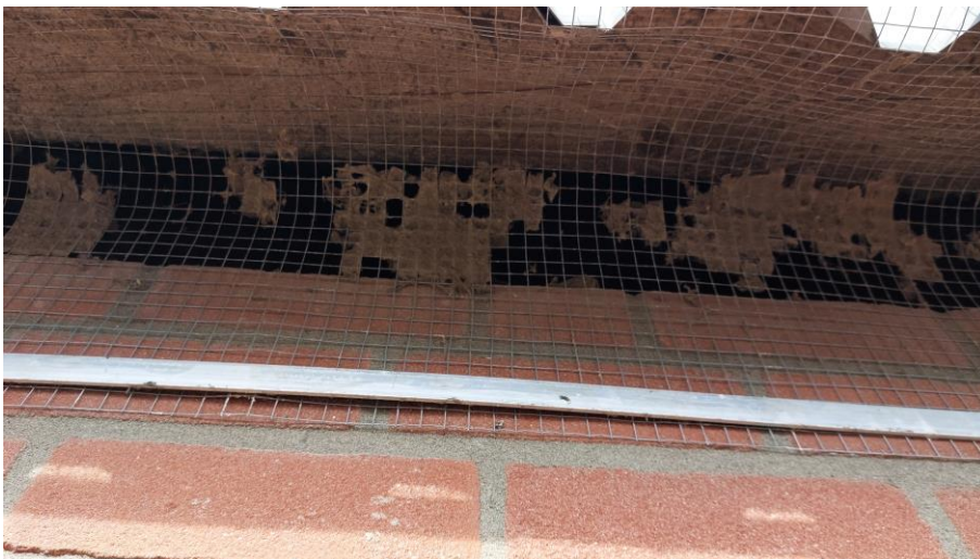
Figuur 4.2.2. Onder de damwandplaten gevels bevindt zich een ongedierte-werend gaas.
