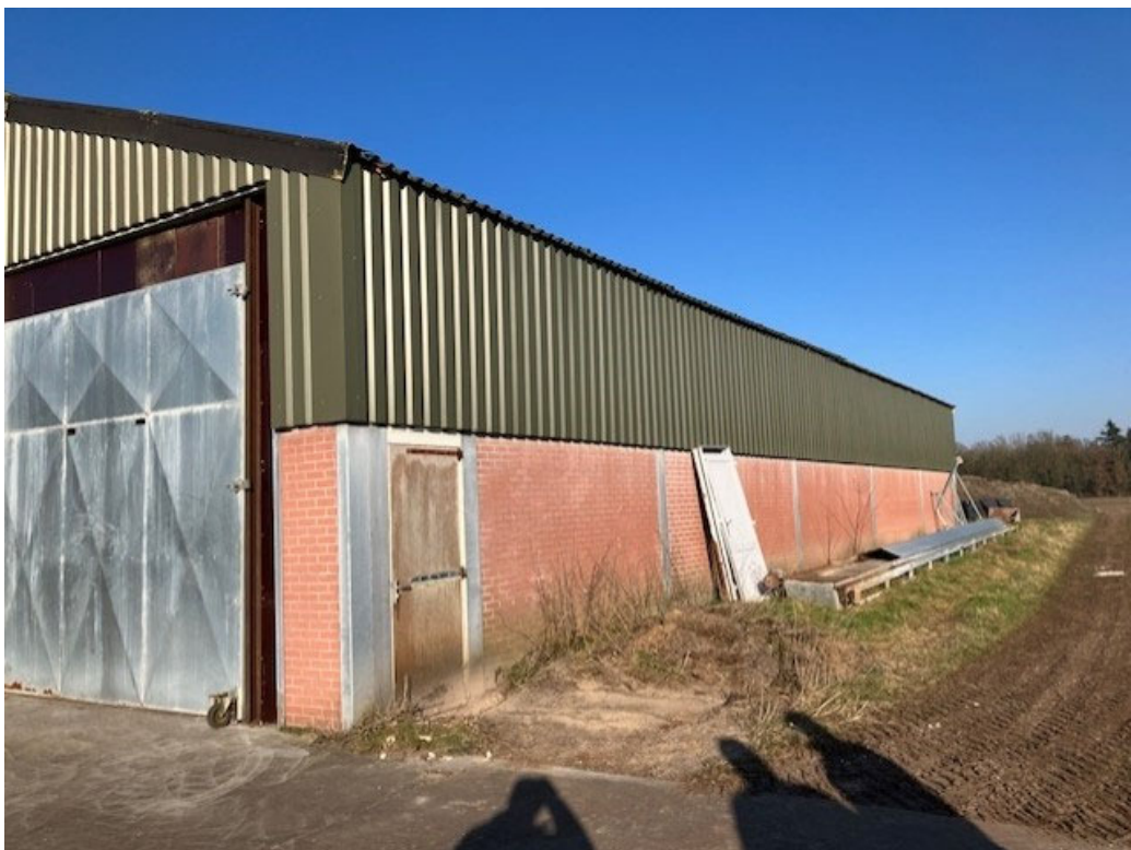
• Afbeelding 12: Te slopen mestloods
