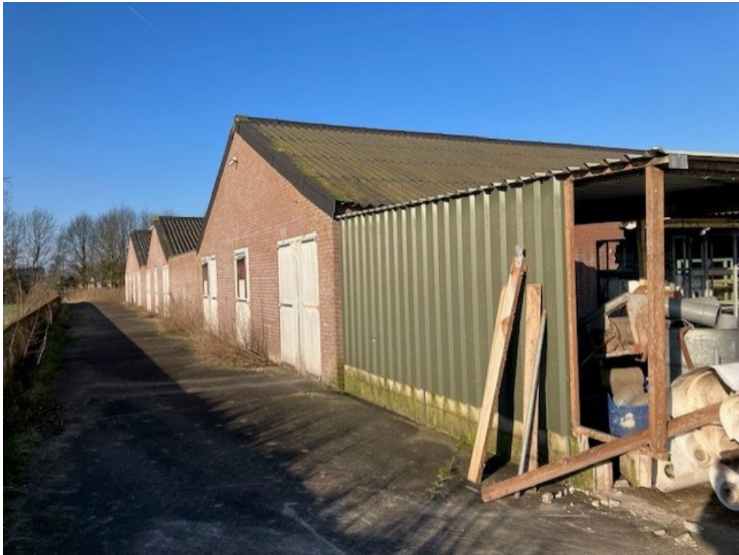
• Afbeelding 15: Achterzijde te slopen kippenstallen
