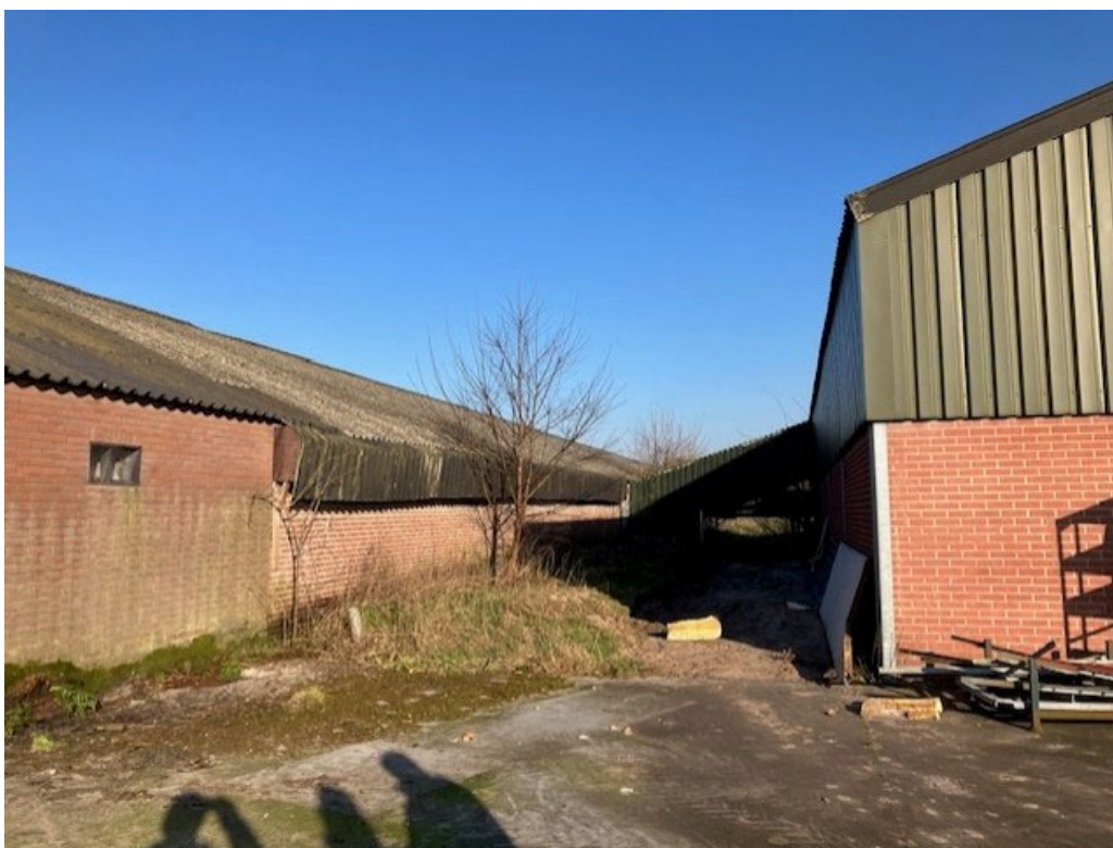
• Afbeelding 14: Ruimte tussen de pluimveestal en mestloods
