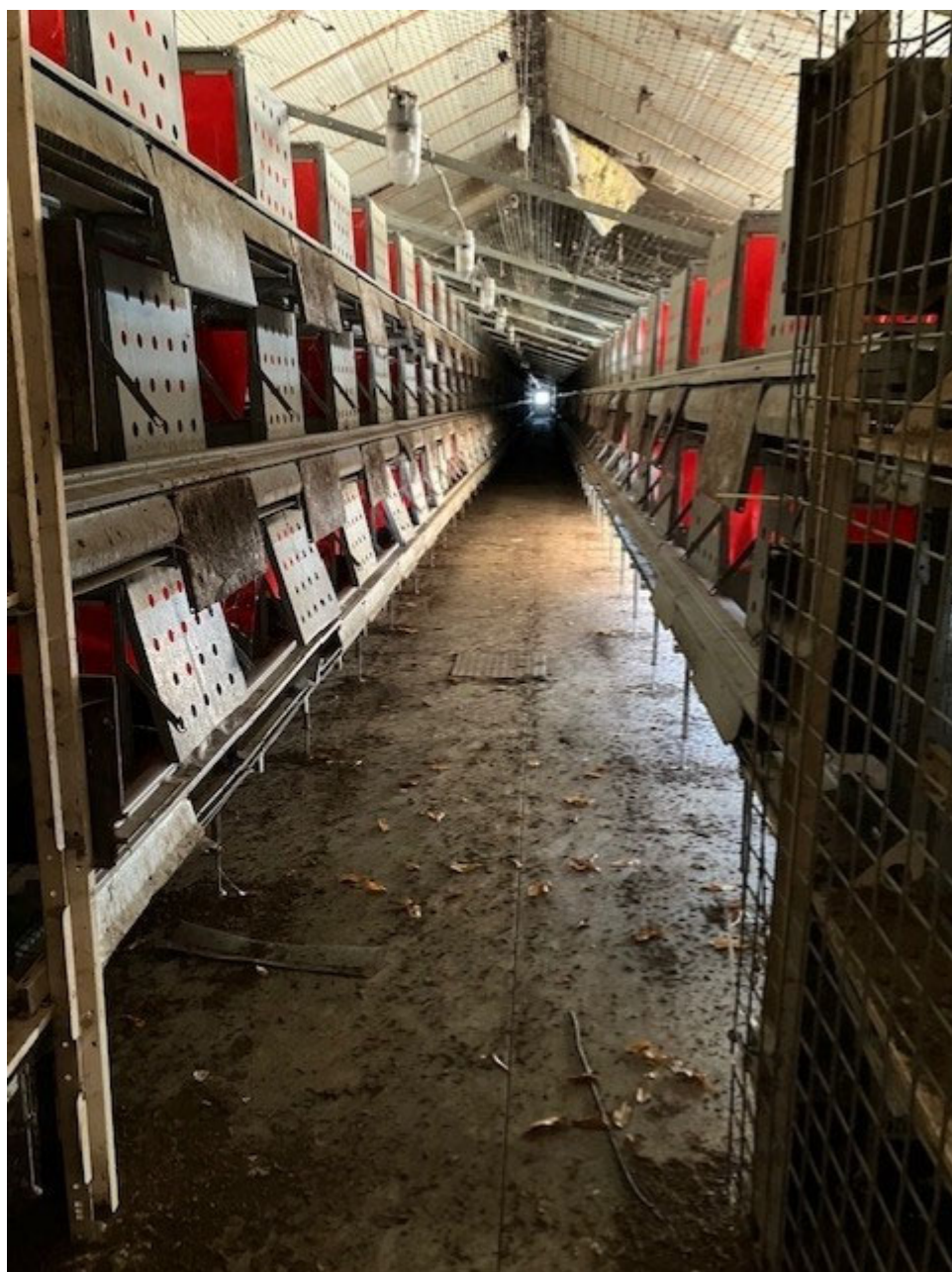
• Afbeelding 18: Binnenzijde te slopen pluimveestal
