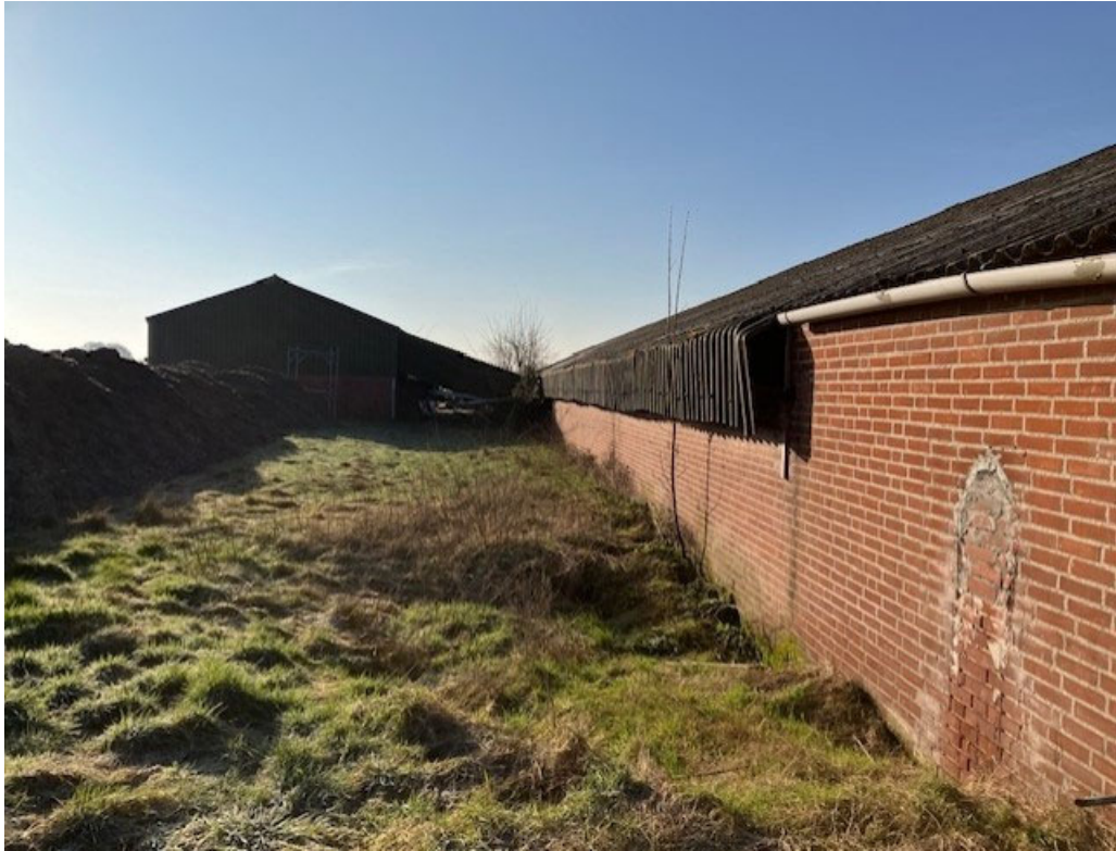
• Afbeelding 9: zijgevel te slopen varkensstallen
