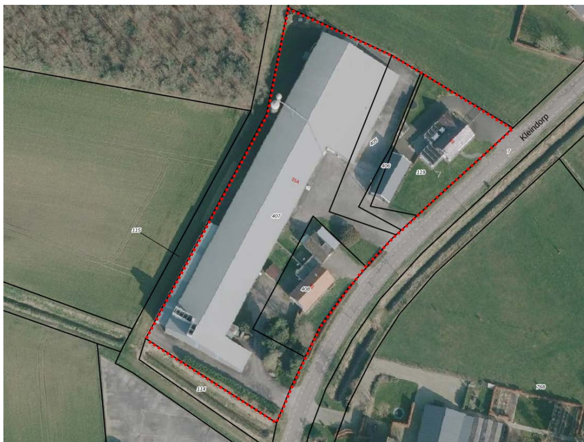
Luchtfoto deellocatie Kleindorp 31-33 (exclusief 'milieuzone – spuitvrije zone') (bron: PDOK viewer)
