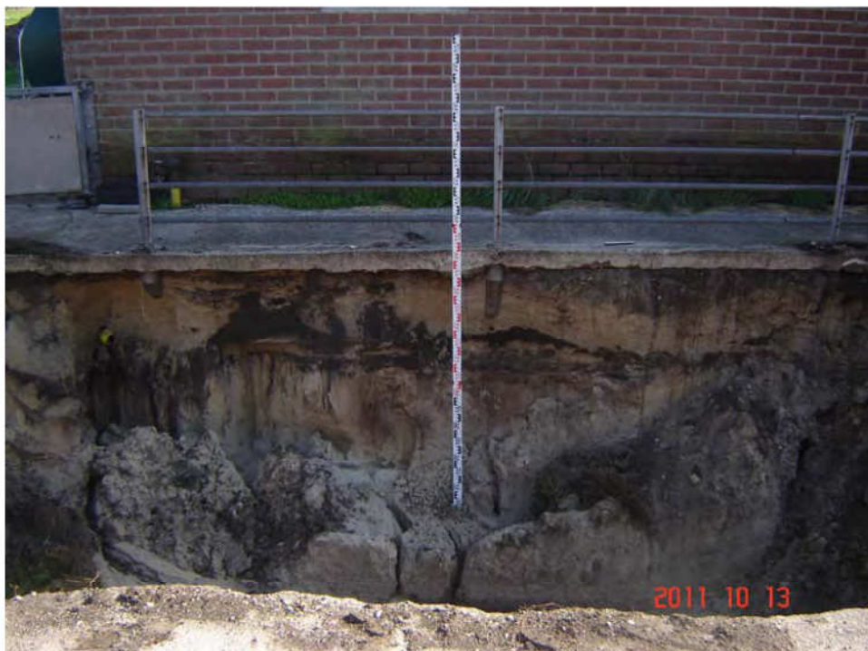
Foto 5 (tank 2, gele pijp is voormalige ontluuchting)
