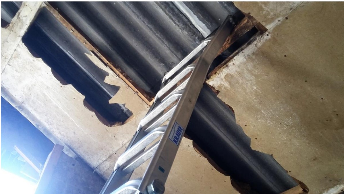
Figuur 8. De ruimten tussen het dak en de platen ertegen zijn alle geïnspecteerd.
