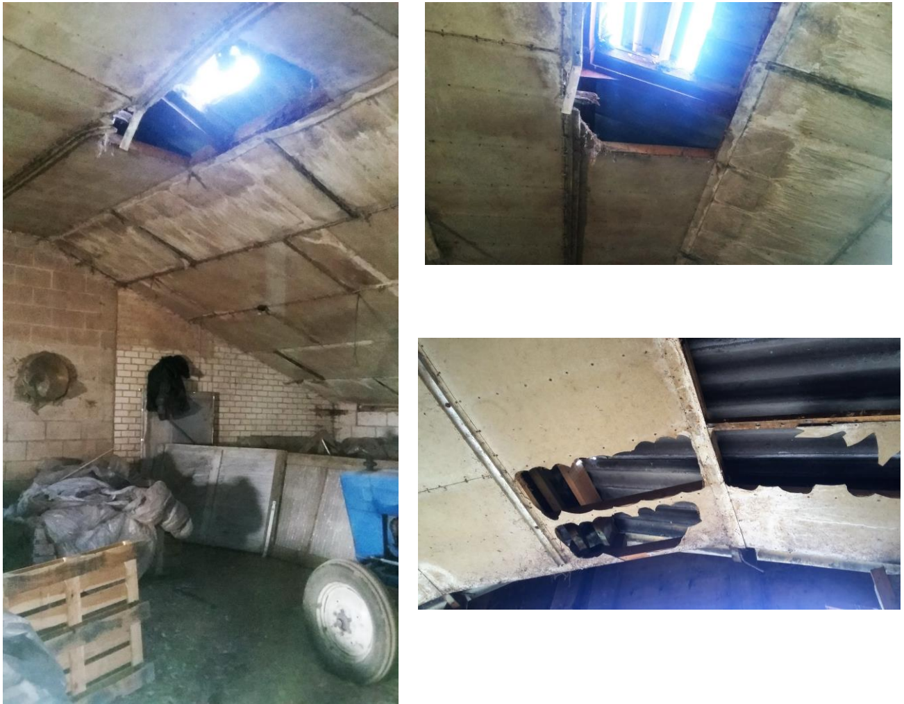
Figuur 16. De ruimten tussen het dak en de platen zijn alle geïnspecteerd; in deze ruimten is geen kerkuilennest aanwezig.
