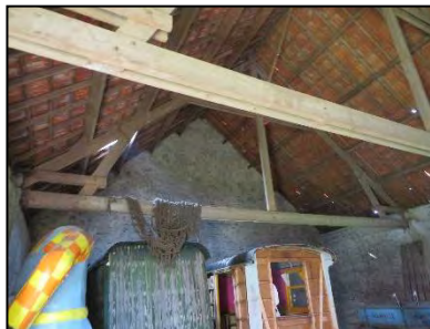
Figuur 12. Onderzijde dak noordelijke grote schuur (westelijk deel).
