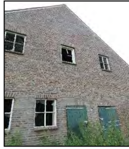
Figuur 10. Oostzijde noordelijke grote schuur.
