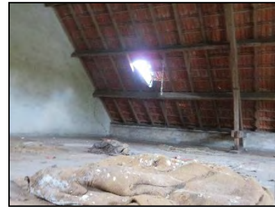
Figuur 11. Zolder noordelijk grote schuur (oostelijk deel).
