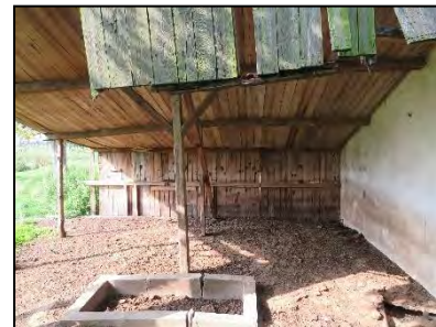
Figuur 14. Kleine open schuur centraal op het noordelijk terreindeel.
