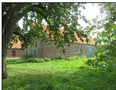
Figuur 4. Oostzijde noordelijke grote schuur.
